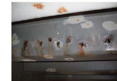
Innenbeschichtung von Stahlhohlkästen
