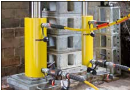
Brückenhub und -vorschub
