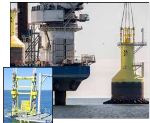
▼ Errichtung des Fundaments für eine Offshore-Windturbine mithilfe eines SyncHoist Systems, um sicherzustellen, dass das Fundament beim Absenken und Positionieren möglichst vertikal bleibt.
