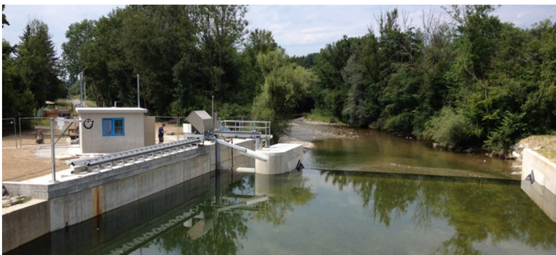
Abbildung 2: Entnahmebauwerk des im Juli 2020 in Betrieb genommenen T 4
