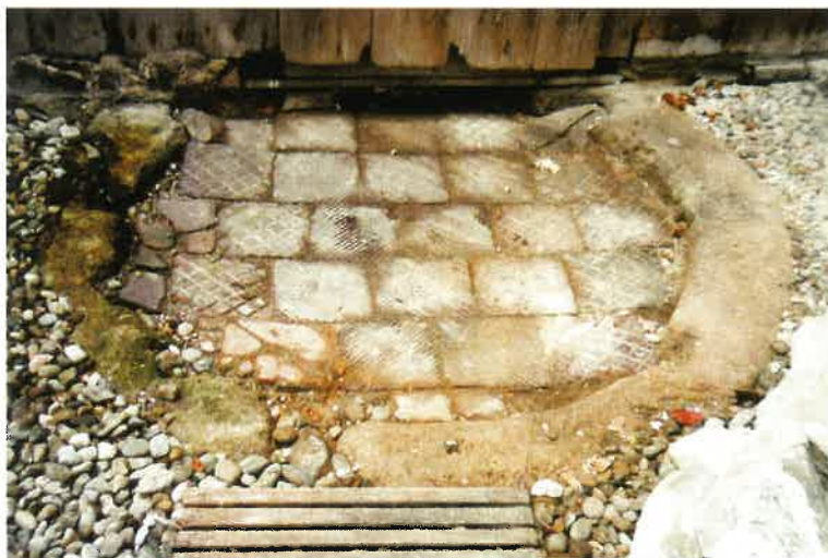
Abb. 18 Zisterne im Hof des Hauses Färbergasse 6
