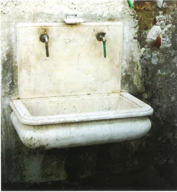
Abb. 47.5 Wandbrunnen beim südlichen Friedhofsportal, aktueller Zustand
