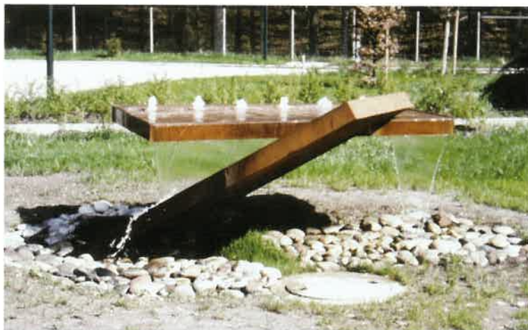
Abb. 42 Brunnen im Außenbereich der Kläranlage
