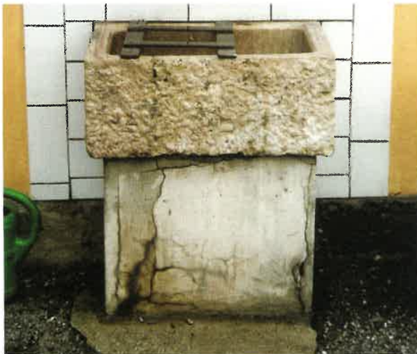
Abb. 47.6 Wandbrunnen auf der Westseite der Aussegnungshalle
