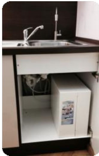
Abb.: Wasserwerk eingebaut
