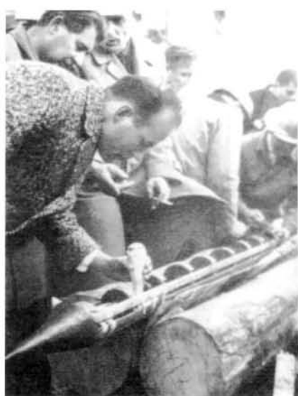
Das Mikrofon wird in die Versorgungsbombe eingelegt.
