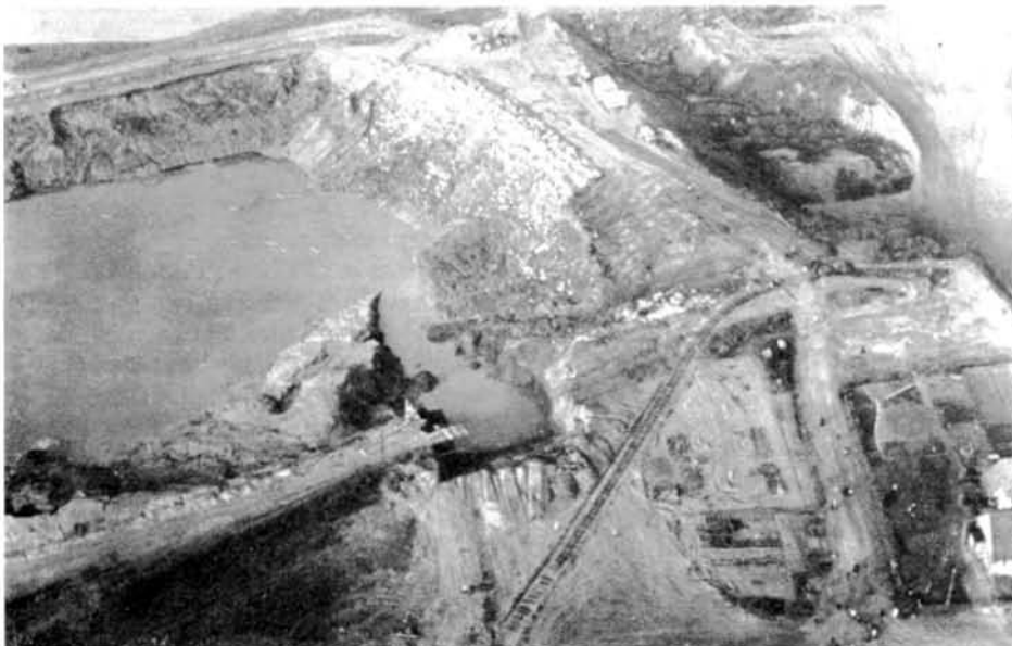
Einbruchsstelle am Klärteich 12 nach Abdichtung. Freigegeben durch das Luftamt, Hamburg, lfd. Nr. 412 213.
