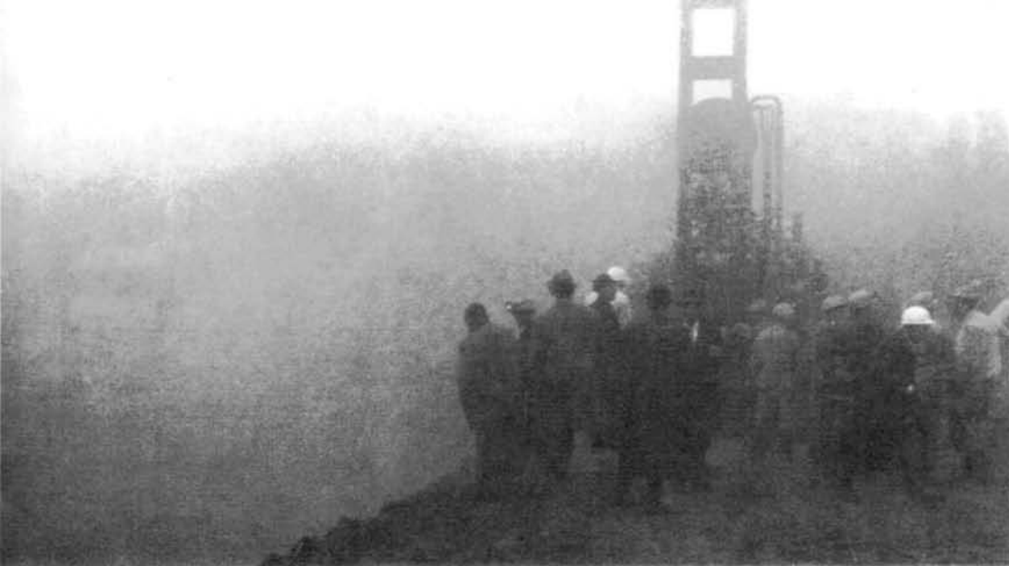
Dichter Nebel behinderte in der ersten Nacht die Rettungsarbeiten in Lengede.
