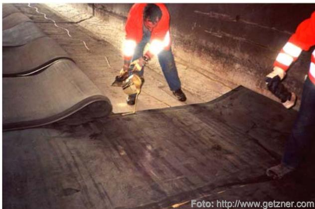
Verkleben der Mattenbahnen mittels Stufenfalz
