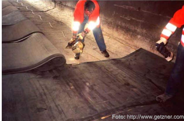
Verkleben der Mattenbahnen mittels Stufenfalz
