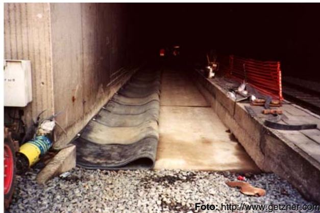
Auslegen der in Rollen angelieferten Mattenbahnen
