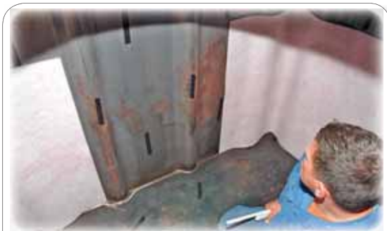
Auskleidung des Tanks mit Schutzvlies
