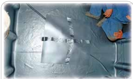
Standortgefertigter Stahltank mit montierter Innenhülle
