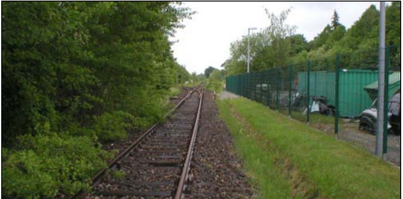
Abb. 13: Ehemaliges Hauptgleis von Westen, weitgehend vegetationslos (Foto: Roger, 18.5.2004)
