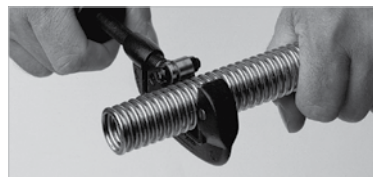
1. Schlauch auf gewünschte Länge im Wellental mit einem Rohrschneider ablängen
