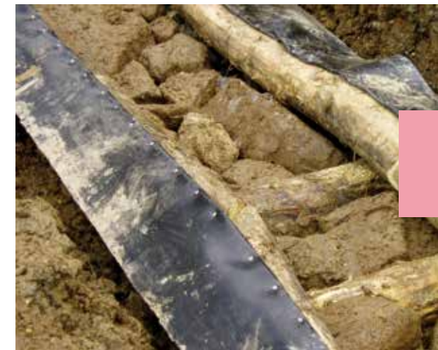
Abb. 7: Die Polypropylenfolie wird am Rundholz befestigt
