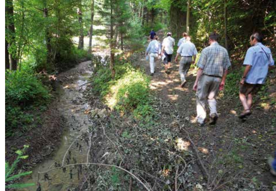
Abb. 11: Unflathgraben bau- aufwärts der Spitzmühle
