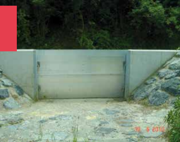
Abb. 9: Hochwassersiel aus Dammbalken
