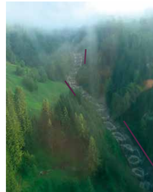
Abb. 9: Die Staffellung zeigte tlw. Funktionsfähigkeit, wurde aber leicht beschädigt. Bei den Außenbögen der Bachachse wurden die Leitwerke hinterspült, eine Sperre wurde vom Diasbach umgangen (lila Linien).
