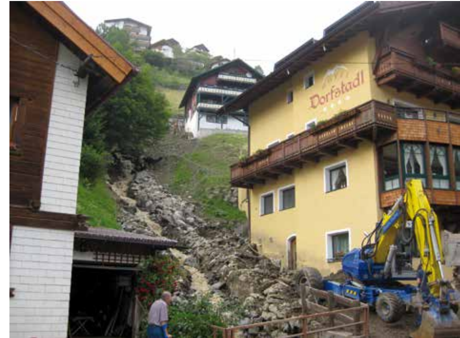
Abb. 16: Am Hotel Dorfstadel kam es durch das Ereignis vom 12.07. zu starken Schäden, ca. 20 Personen mussten hier evakuiert werden. Schadenssumme ca. 800.000 Euros (Auskunft Besitzer)
