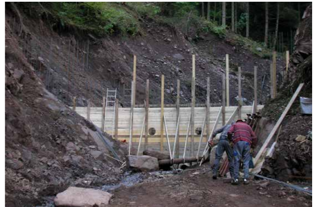
Abb. 1: Konsolidierungssperre bzw. Bogensperre (Quelle: WBV Trient)
