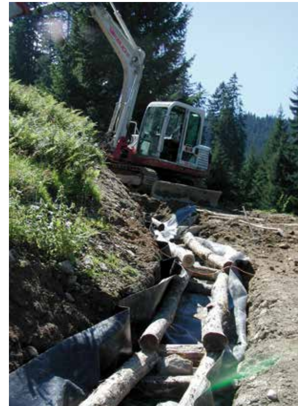
Abb. 6: Einbringung der Robinienhölzer
