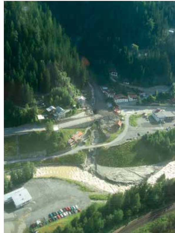
Abb. 6: Geschiebeablagerung im Siedlungsgebiet, das Gerinne ist ausgewaschen, die Ablagerungen in der Rosanna erkennbar.
