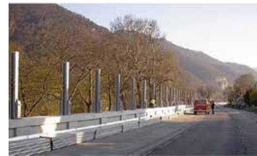
Abb. 16: Aufbau der Durchgangssteher
