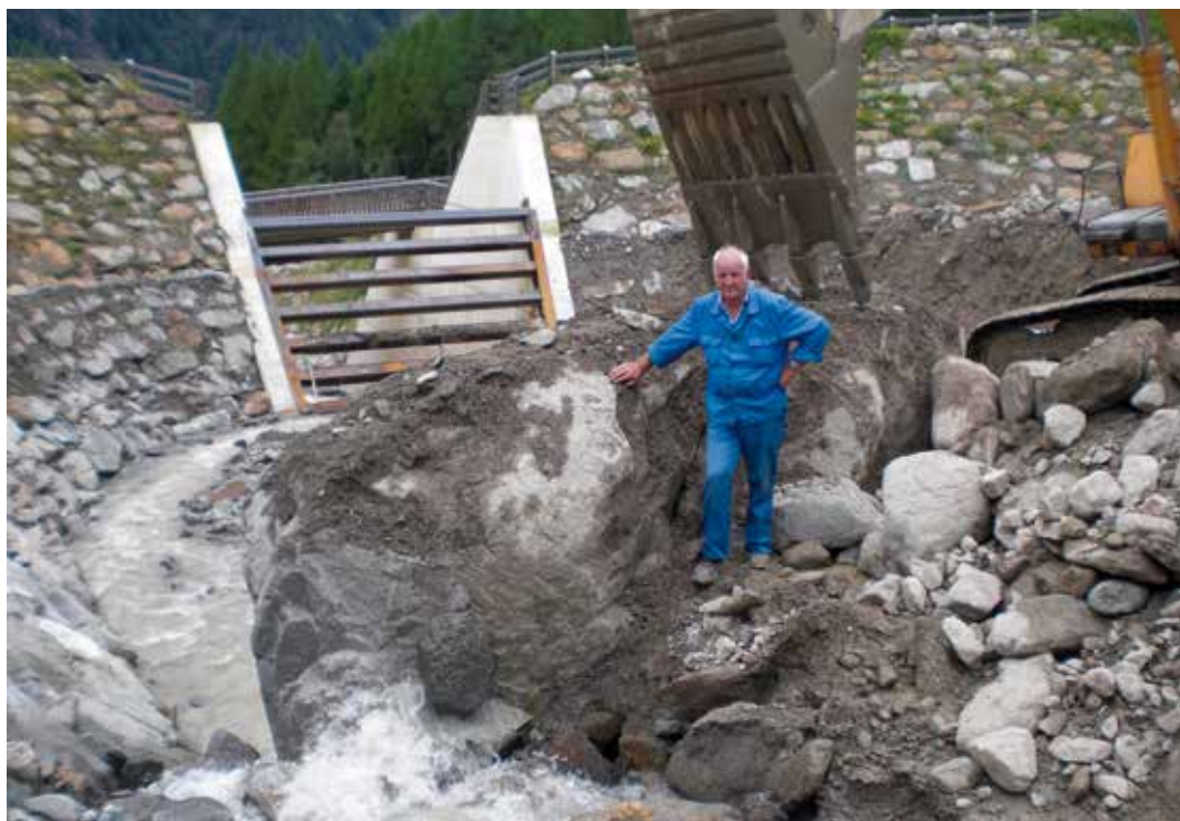
Abb. 22: Selber Block aus einer anderen Blickrichtung; die Sperrerbalken hätten der extremen Punktlast vermutlich nachgegeben.
