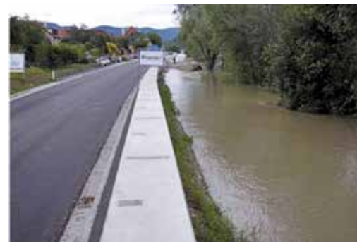
Abb. 14: Hochwasserschutzmauer entlang der Donau
