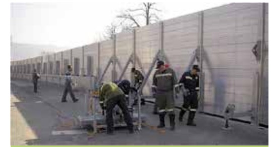
Abb. 17: Vollaufbau des Hochwasserschutzsystems (Phase 5)
