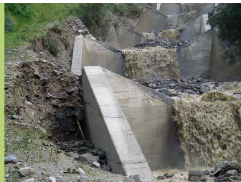
Abb. 10: Die Konsolidierungssperren wurden als „Kastensperre“ errichtet. Da keine (Flügel-) Einbindung in den Hang besteht, können die Sperren bei einer Überlastung der Abflusssektion umfahren/ seitlich ausgewaschen werden.
