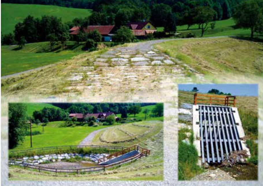
Abb. 2: RHB Lengbach: Dammkrone, Ein- und Aus- laufbauwerk
