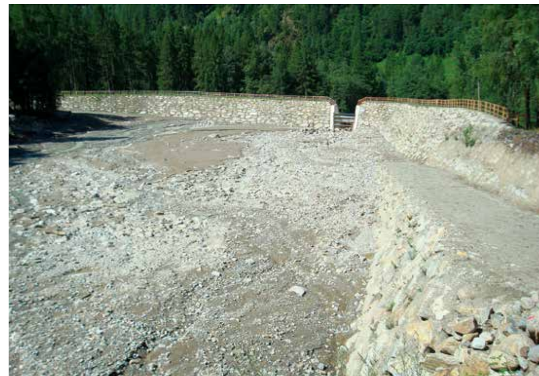
Abb. 24: Teilverfülltes unteres Becken: hier wurden ca. 20.000 m 3 abgelagert.
