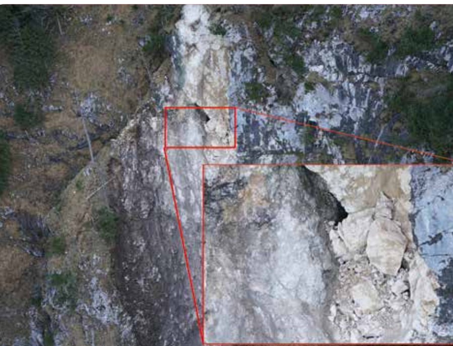
Abbildung 5: Foto des Abbruchgebietes, aufgenommen mit der Drohne
