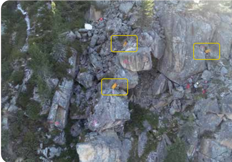
Abbildung 6: oben: Fissurometer (gelbe Rechtecke) und unten Messprismen (roter Kreis)
