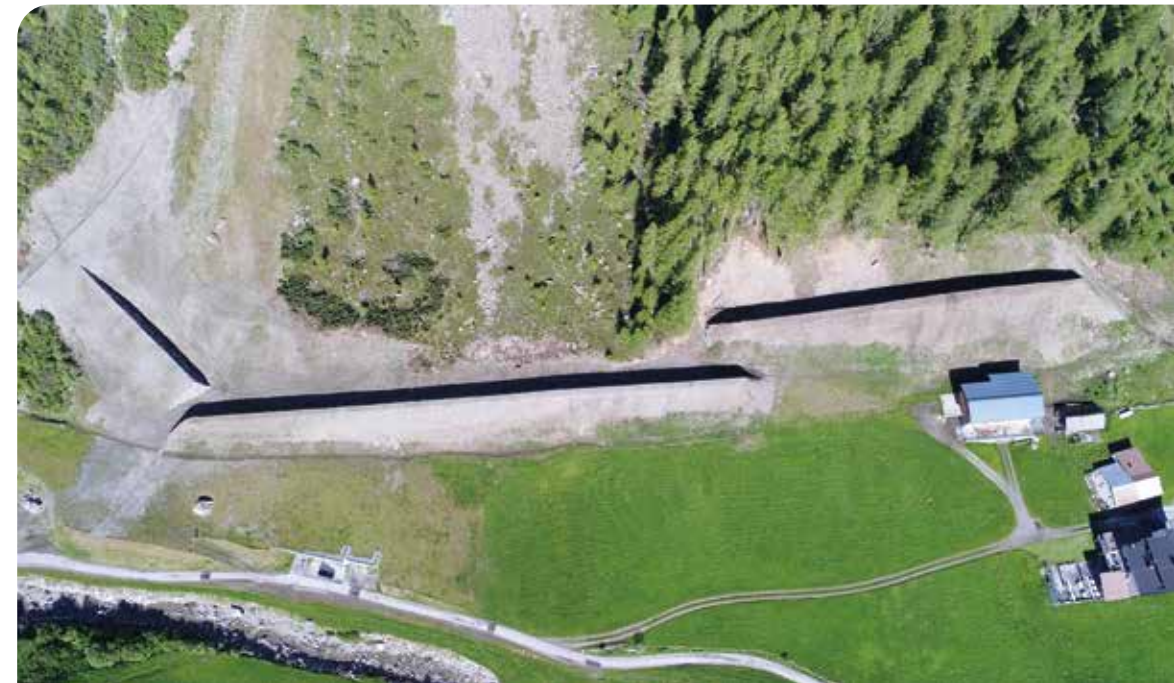
Abbildung 8: Steinschlagschutzdammverband nach Fertigstellung (Silvrettaseilbahn AG, 2019)
