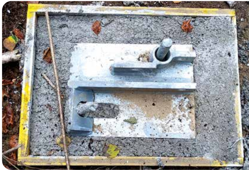
Abbildung 1: Beispiele für die Verwendung von Mikropfählen bei Schutzbauten; Stützenfundament (oben); Seilanschlagpunkt bergseitiger Abspanner (unten)
