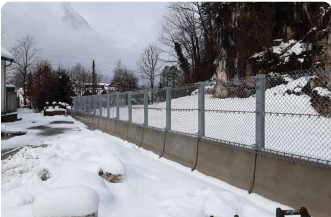
Abb. 9: Fertig montiertes Steinschlagschutzsystem
