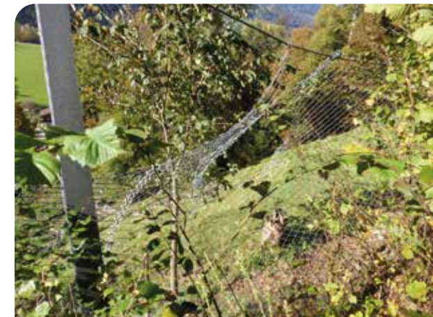
Abbildung 4: Das vom Betonblock durchgestanzte Loch im Netz (Foto: Tschugmell)
