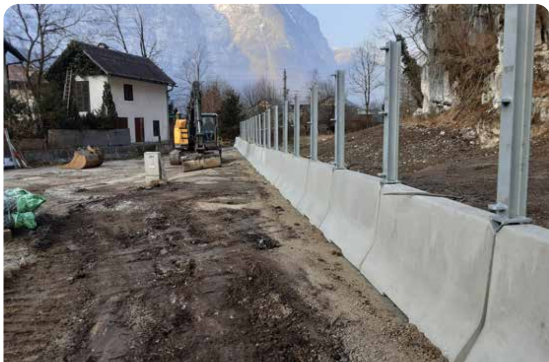
Abb. 7: Versetzen der Betonelemente und gleichzeitige Montage der Stahlstützen
