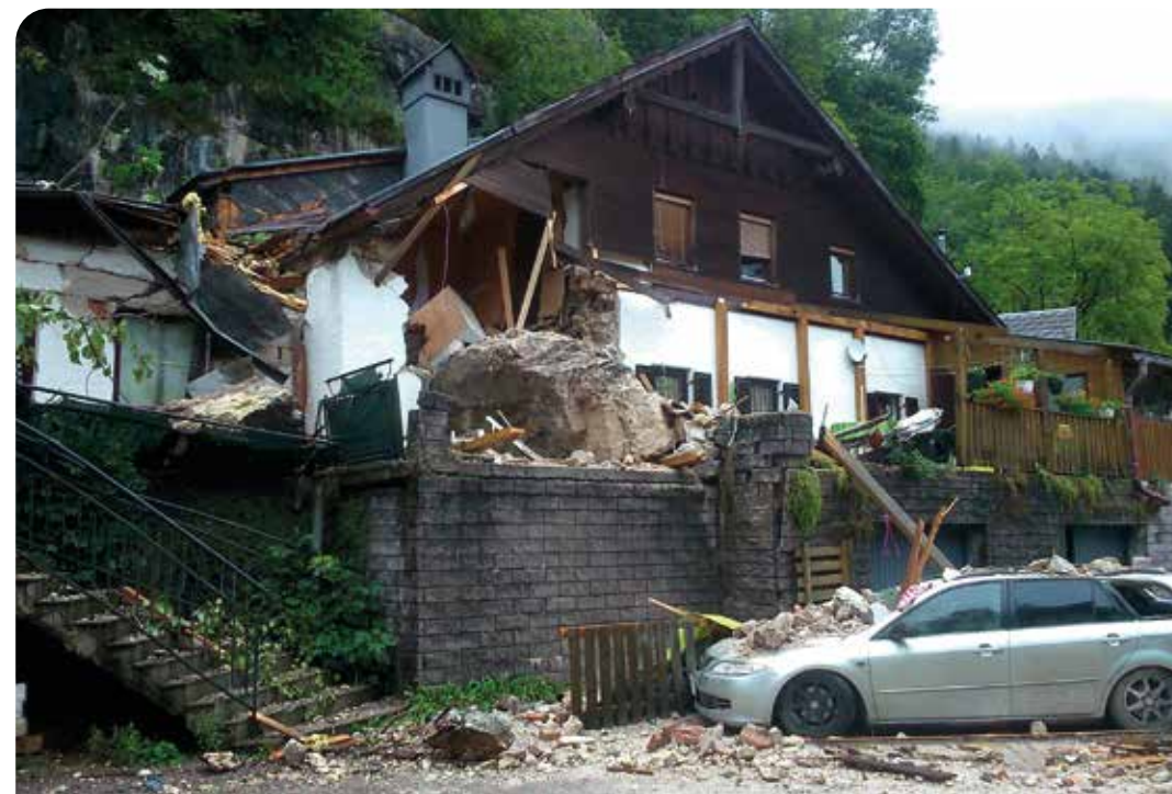
Abb. 6: Teilweise zerstörtes Wohngebäude nach Felssturz, größter Einzelblock mit ca. 10 m 3
