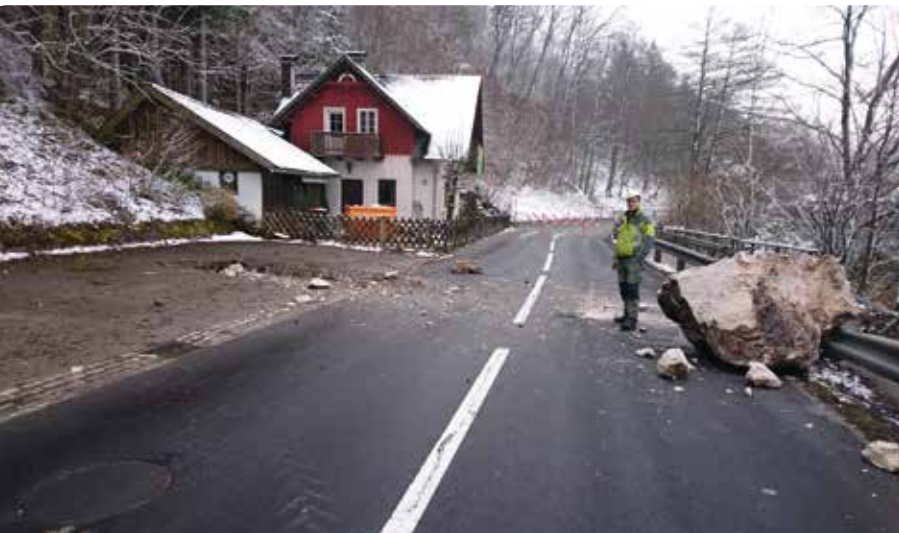
Abbildung 3: WLV-Förster Christoph Hofmann vor 5 to-Block. Die Einschlagstelle nach einem finalen 30 m-Satz des Blockes liegt nur rd. 15,0 m neben dem Objekt Weißenbach 1.
