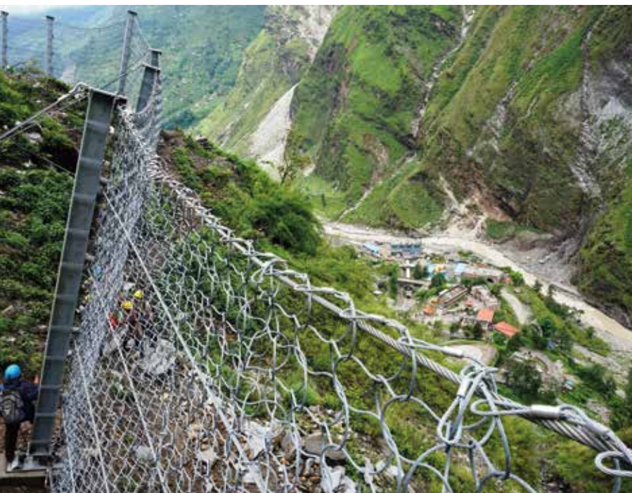
Abbildung 4: Fertiggestellte Schutznetze vom Typ TSC-3000-ZD oberhalb des Wasserkraftwerkes
