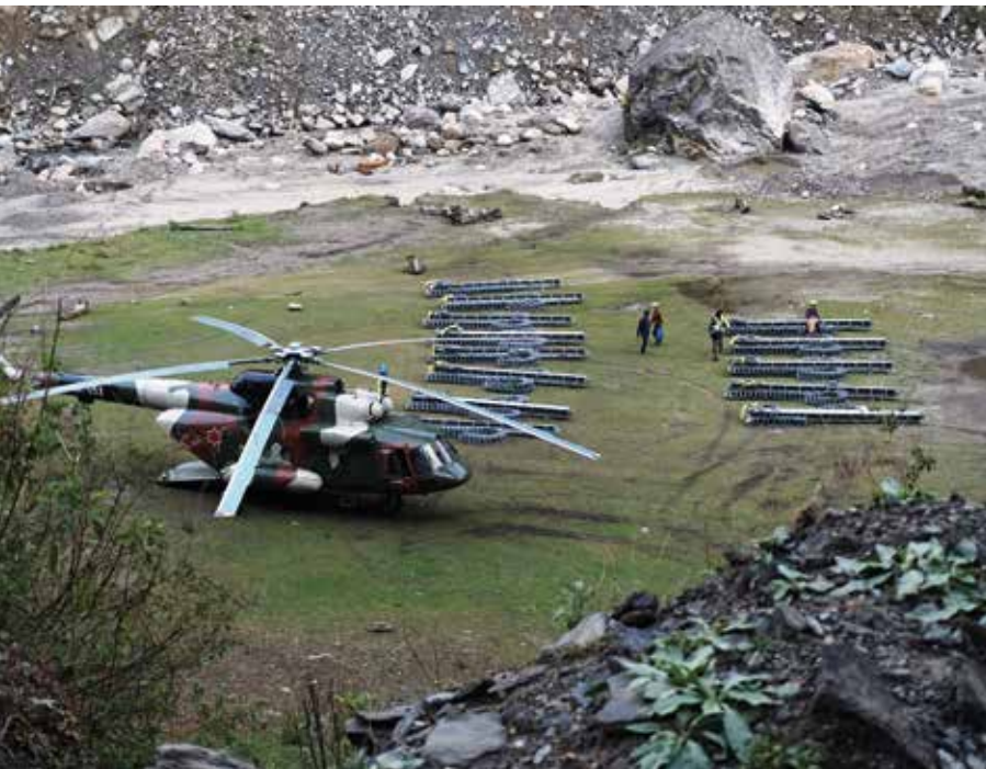
Abbildung 3: Vorbereitungen zur Helikoptermontage der Steinschlagschutzsysteme mit einer russischen Mil Mi-17 Transportmaschine der nepalesischen Armee
