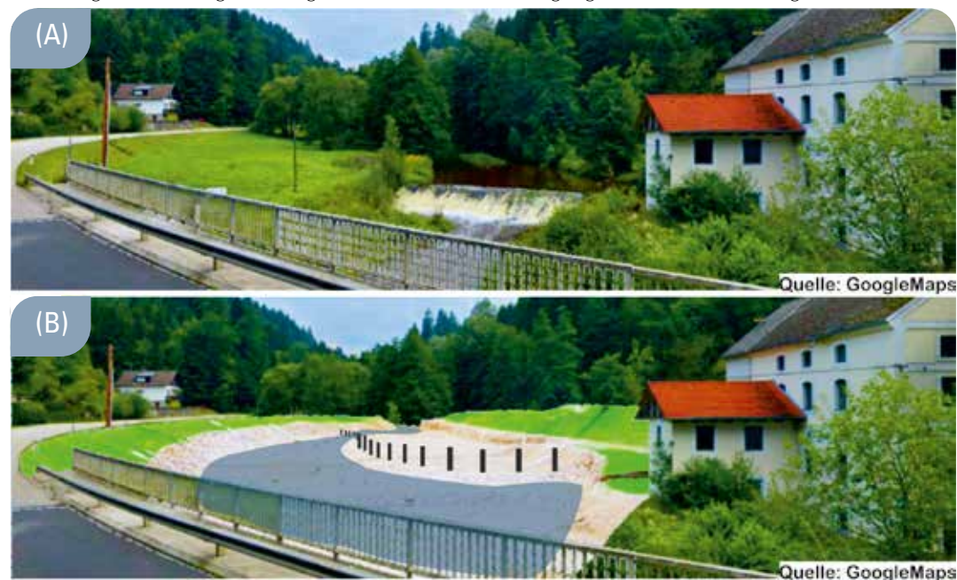
Abbildung 1: (A) Aktuelles Bild mit Blick flussaufwärts auf die Wehranlage in der Naarn im Bereich Gasthaus Kuchlmühle. (B) Geplanter Wildholzrechen im selbigen Bereich (Quelle: In Anlehnung an Hödl, 2021)
