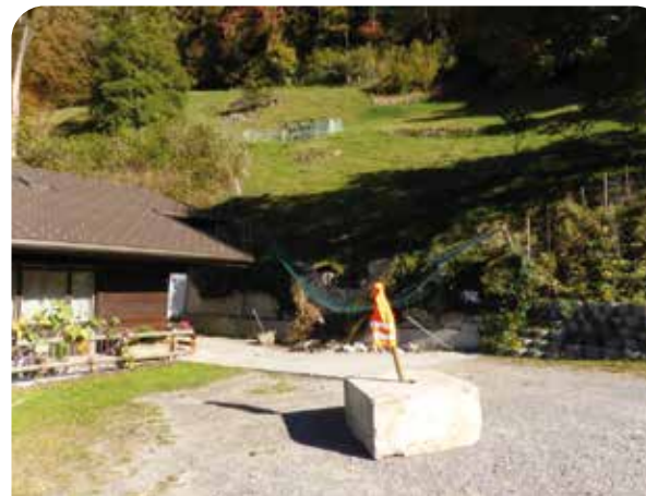
Abbildung 3: Der abgestürzte, 0,5 m³ große Betonblock (Foto: Tschugmell)
