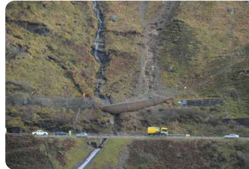
Abbildung 3: Geobrugg SL-150 Barriere nach dem Rückhalt einer Hangmure im Jahr 2015.
