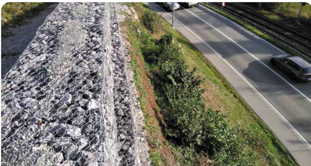
Abbildung 8: Gabionen-Damm mit Unterkonstruktion in bewehrter Erde
