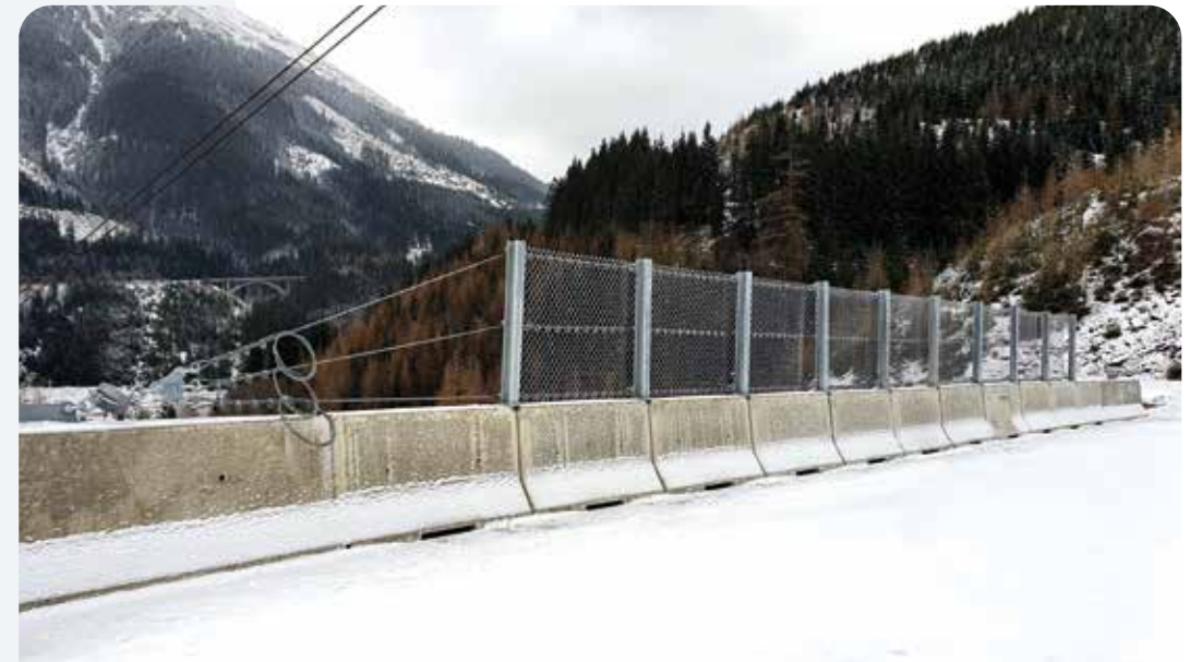
Abb. 1: Verbaureihe auf dem Testgelände am steirischen Erzberg
