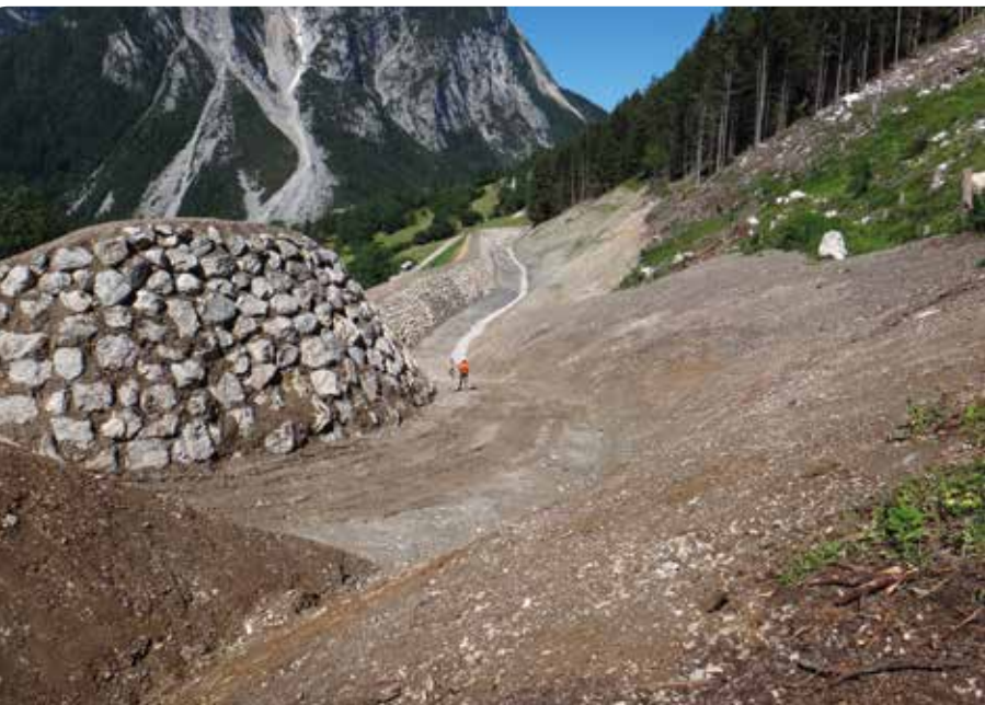
Abbildung 8: Fertiggestellter Steinschlagschutzdamm
