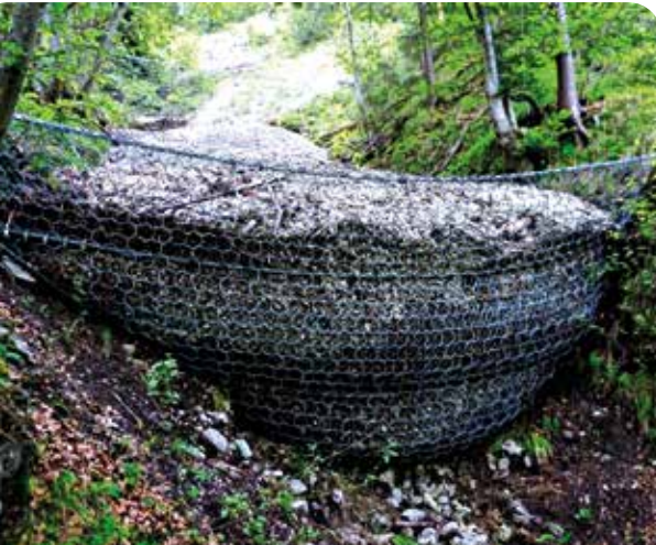
Abbildung 8: Bautype der Hangmurenschutznetze (Foto: Trumer Schutzbauten GmbH)
