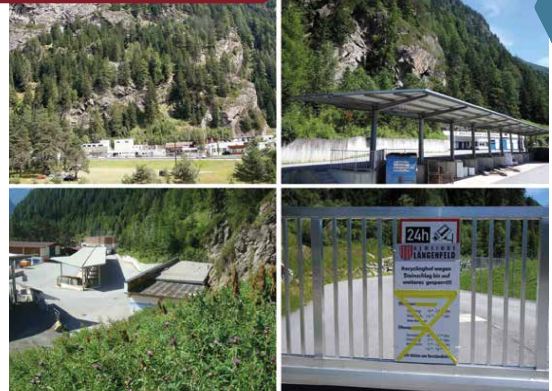
Abbildung 1: Links oben: Übersichtsfoto der Kläranlage, des Bauhofes und des Recyclinghofes der Gemeinde Längenfeld; Rechts oben: Überdachte Containerstellplätze für die Wertstoffsammlung, im Hintergrund das Bürogebäude des Recyclinghofes; Links unten: Überblick über das Areal des Recyclinghofes, zwischen Flugdach und Stützmauer befindet sich der Einwurfbereich für die Kunden; Rechts unten: Sperrung des Geländes als Folge eines Steinschlagereignisses im Kundenbereich mit Personen- und Sachschäden.
