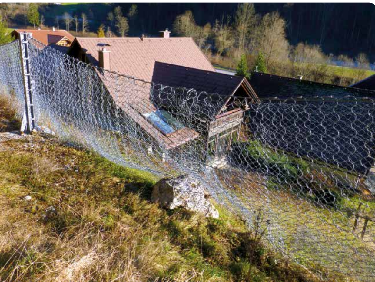
Abbildung 6: Rollend-gleitend abgegangener, scheibenförmiger Felsblock mit rund 2 Tonnen Gewicht beim Ritzinger Felssturz
