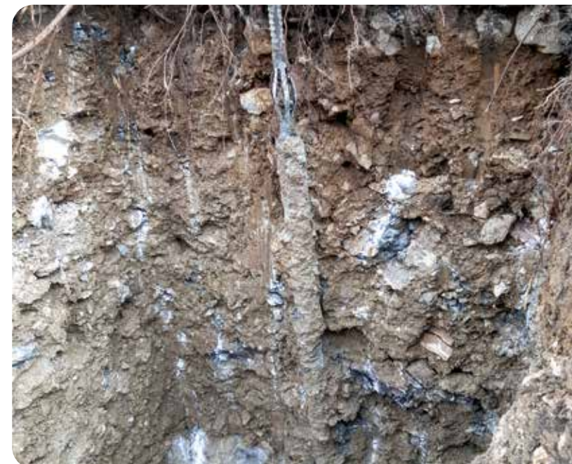
Abbildung 3: Mittels Bagger freigelegter Probemikropfahl der Bodenkatgorie Bindiger Schotter (GU)
