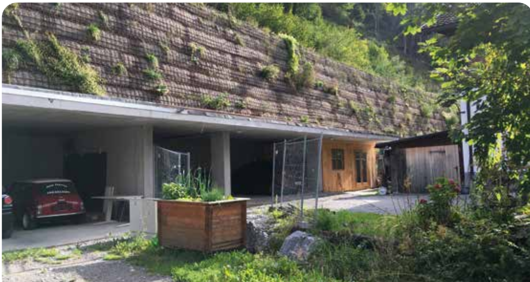
Abbildung 7: Damm aus bewehrter Erde mit einer Wirkhöhe von 4 m und 1.200 kJ Bemessungsenergie – die Garage wurde vom Grundeigentümer mit entsprechender Bemessung zuvor errichtet
