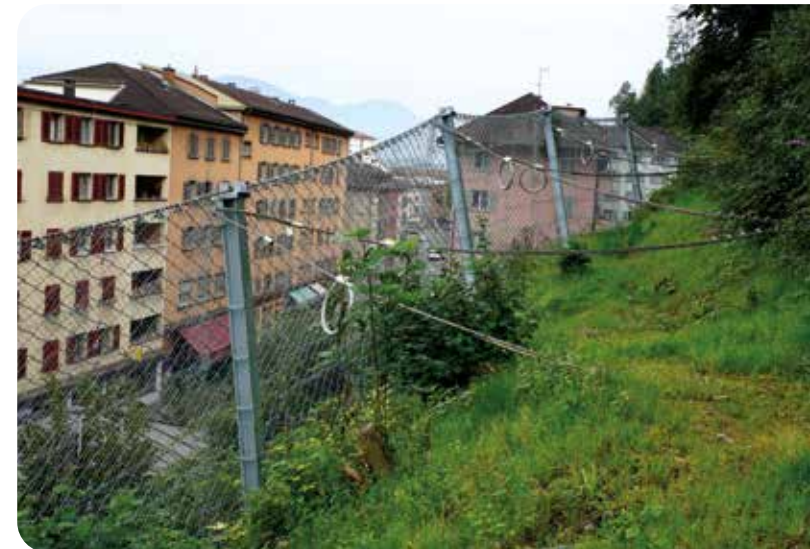
Abbildung 4: Die Hangmurenbarriere lässt sich auch nahe an Infrastrukturen installieren.
