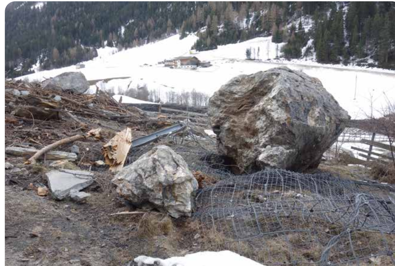
Abbildung 5: Zerstörte Randfelder des bestehenden Steinschlagschutznetzes im orographisch rechten Stirnbereich der Sturzmaterie
