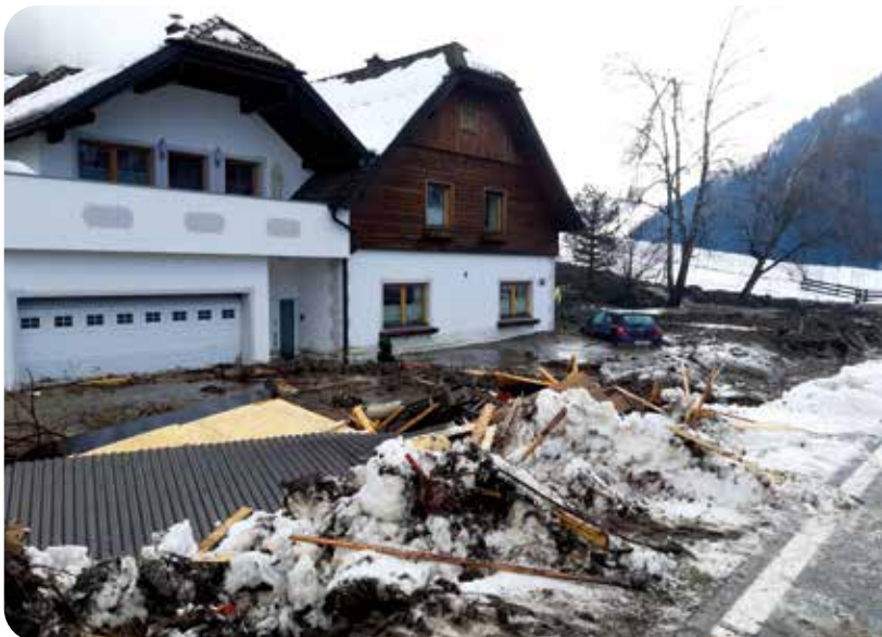
Abbildung 4: Schäden an Gebäuden und Carports bzw. Autos
