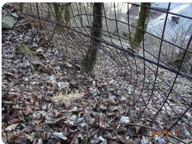
Abbildung 5: Vorverfüllung und Durchschlag durch einen Fangzaun im Bereich von Profil Nord 4 (Mölk, 2019) oberhalb Schallmooser Hauptstraße 40
