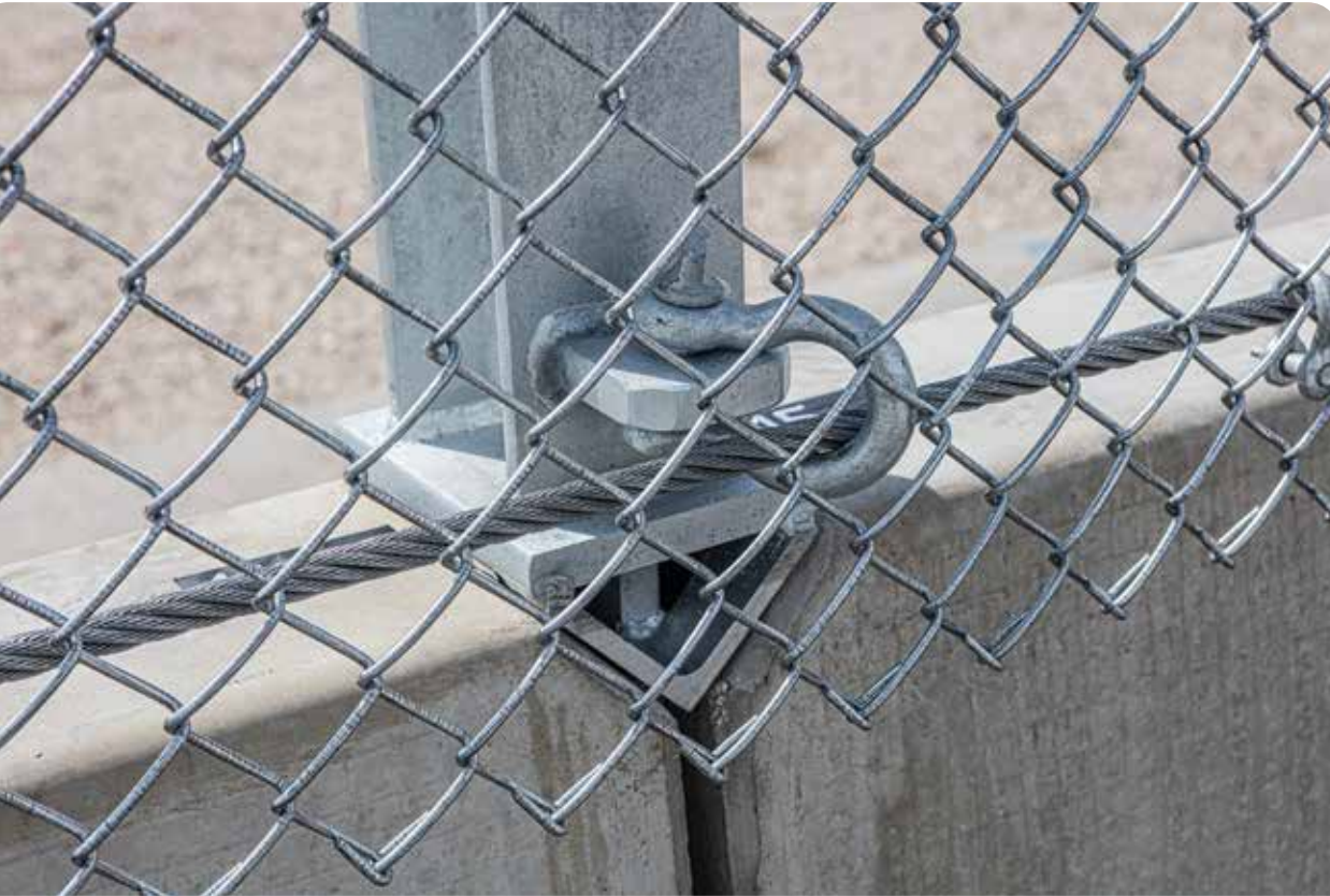
Abb. 2: Steherdetail mit Seilführung und Kupplung
