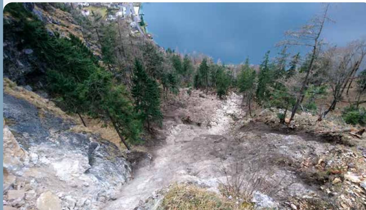
Abbildung 1: Blick vom Ablösebereich in die Sturzbahn der Felssturzmassen
