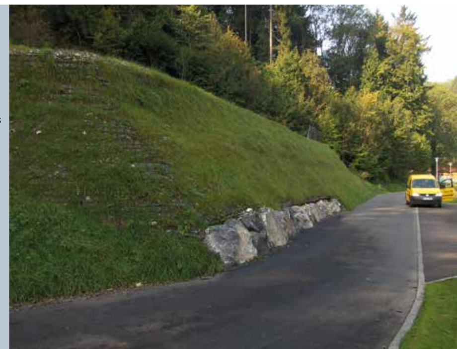
Abbildung 3: Fertiggestellter Steinschlagschutzdamm. Durch diesen Damm konnte die Gefahr des Steinschlages reduziert werden. Nun ist es möglich, den Hinweisbereich „Steinschlag intensiv“ zurückzunehmen.
