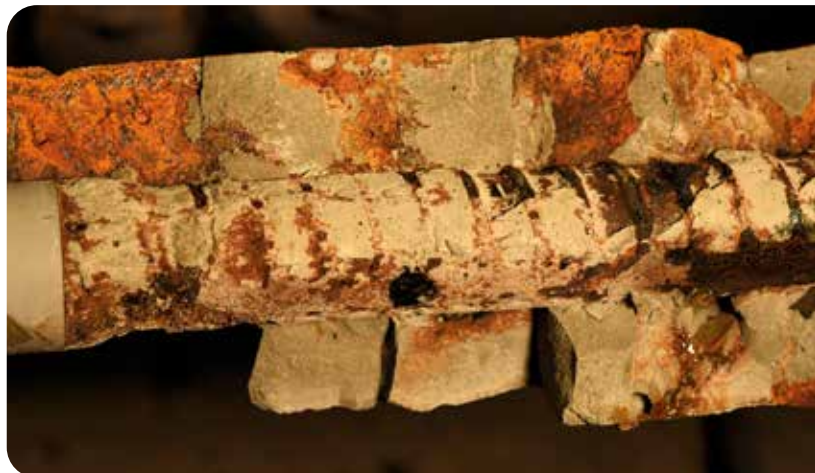
Abbildung 5: Künstliche Korrosionsnachbildung an Mikropfählen; blankes Tragglied (oben), verzinktes geschädigtes Tragglied (unten)
