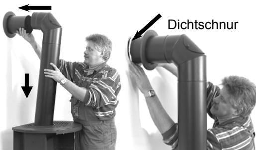
Abb. 7: Montage Rauchrohr
