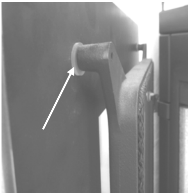
Abb. 9: Silikonring zwischen Gusstür und Dekorglas
