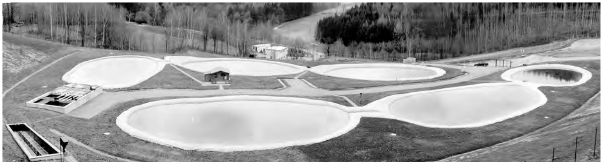
Abb. 5: Großtechnisches Constructed Wetland.
