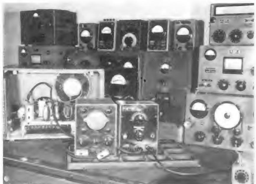
Bild 8. Der Frequenzwobbler mit Meßsender, Oszillograf und Superhet, am Meßplatz betriebsfertig zusammengesaltet
