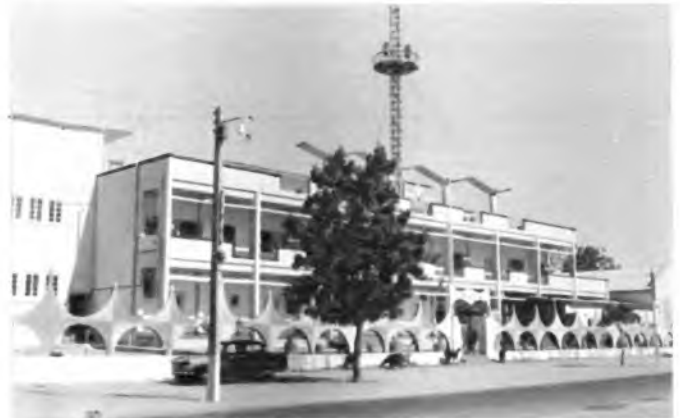
Bild 1. Die erste Fernsehstation im Sudan, untergebracht in einem kleinen Hotel. Auf dem Dach der Sendemast mit Plattform für die Richtfunk-Endstellen
