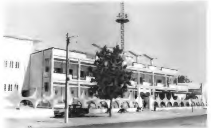
Bild 1. Die erste Fernsehstation im Sudan, untergebracht in einem kleinen Hotel. Auf dem Dach der Sendemast mit Plattform für die Richtfunk-Endstellen
