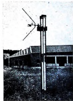
Bild 3. Am Befestigungsmast bis auf 3 m Höhe verstellbare Empfangsantenne „Fesa Corner 3a“ von Hirschmann für den Fernsehbereich IV/V
