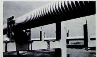
Bild 2. Die Verlegung des Kabels erfolgt über gepolsterte Rollen (links); dann wird es von den Rollen genommen (rechts) und angeschliffen.
