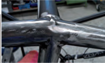
Reinigung der Grundstruktur aus Stahl
