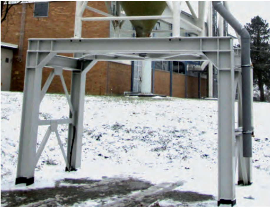
Untergestell mit ZinkPlus/Farbbeschichtung und Oberteil nur mit Farbbeschichtung nach 4 Jahren im Einsatz
