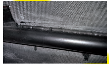
Aufbringen des Faserverbundwerkstoffs auf die Grundstruktur ...
