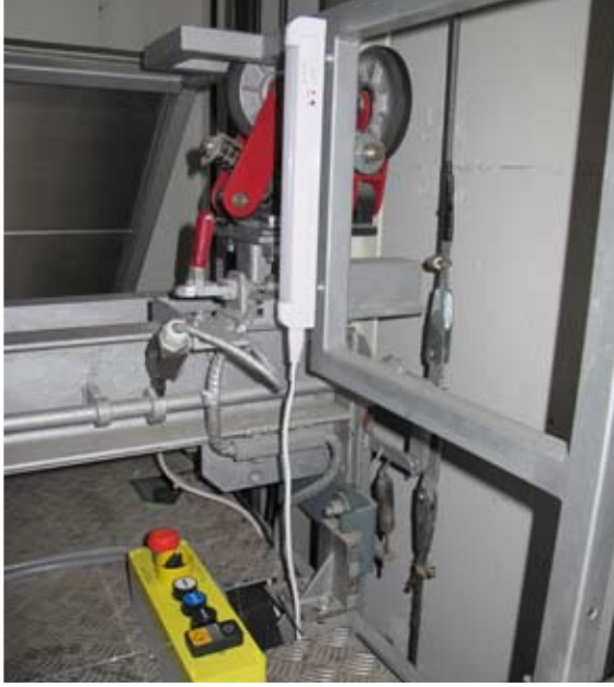
Befestigung der W+W Notleuchte am Fahrkorbgeländer.
