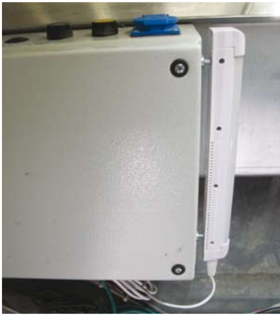
Befestigung der W+W Notleuchte am Dachsteuerkasten.
