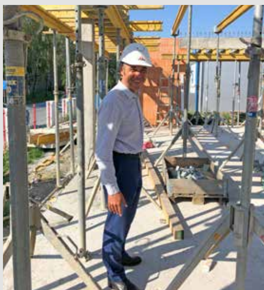
Der Neubau des Firmengebäudes geht zügig voran. Schon im Dezember soll das neue Lager bezogen werden und im Mai das neue Firmengebäude.
