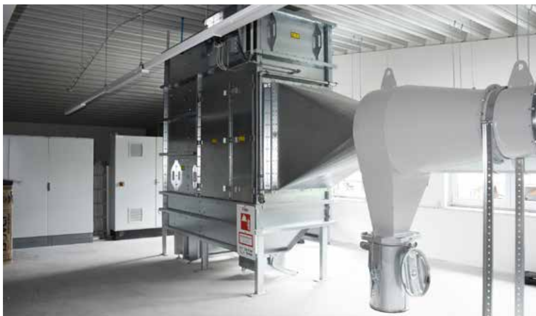
Die Absauganlage von Scheuch Ligno sorgt für ein nahezu staubfreies und flexibles Arbeiten.
