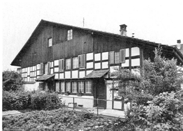
Uster. Nänikon. Stationsstrasse 8/10. Ehem. Kleinbauernhaus Vers. Nr. 1027/28. Nach der Renovation 1972.
