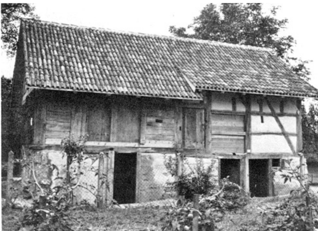
Winterthur. Stadel. Speicher Vers.Nr. 367/368. Oben: Zustand 1969; unten: nach der Restaurierung 1970/71.
