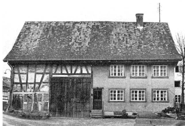
Andelfingen. Marktplatz. Ehem. Blaufärberei und Bauernhaus. Abgebrochen im Sommer 1969.
