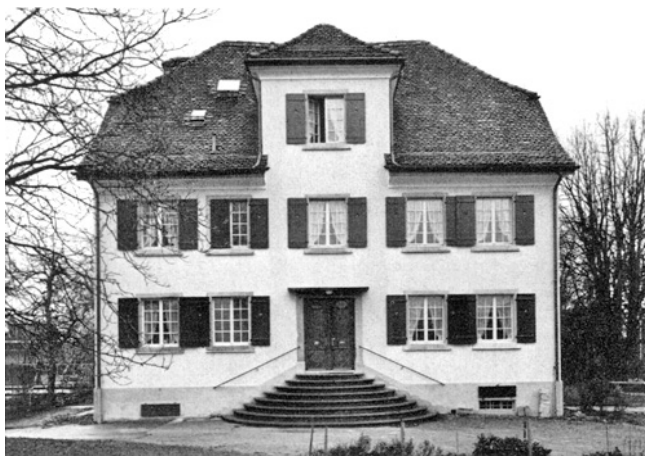
Greifensee. Sog. Bollierhaus. Nach der Renovation 1973/74.
