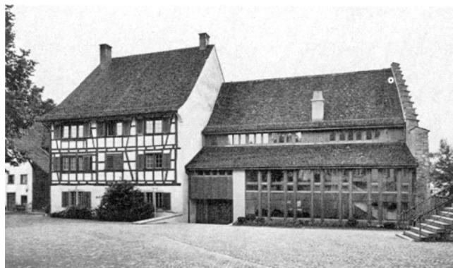
Greifensee. Sog. Schloss-Scheune (ehem. romanischer Palas). Nordostseite. Oben: vor dem Umbau; unten: nach dem Umbau 1969/70.
