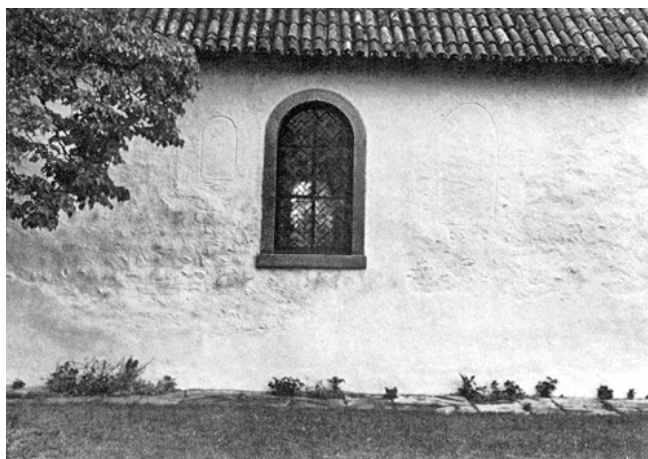
Nürensdorf. Breite. Oswaldkapelle. Südmauer. Nach der Restaurierung 1969/70.
