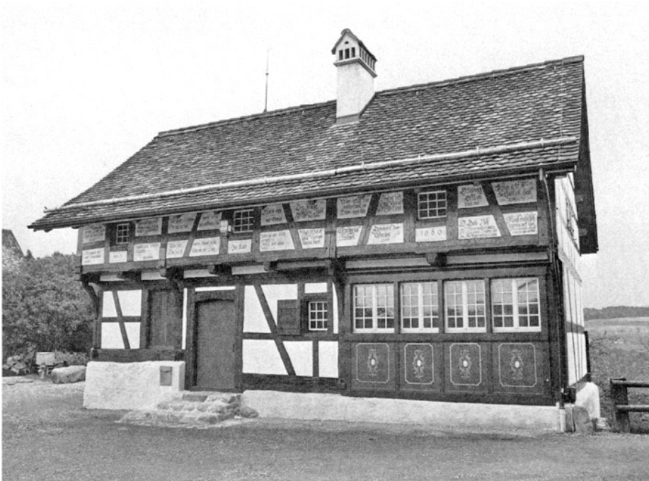
Turbenthal. Chäfer. Ehem. Speicherstöckli Vers. Nr. 948. Oben: vor der Restaurierung; unten: nach der Restaurierung 1971–1973.
