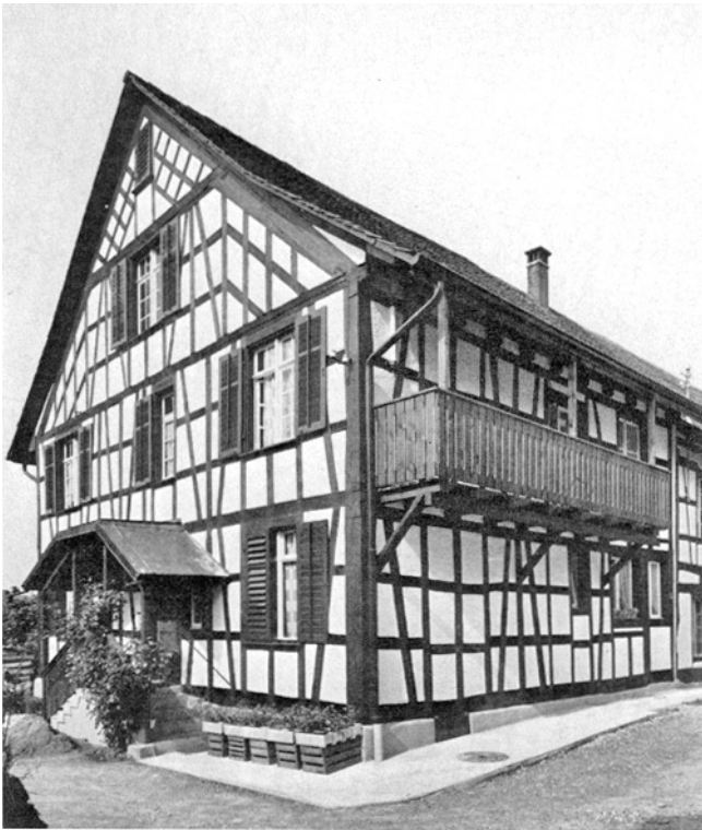
Trüllikon. Rudolfingen. Wohnhaus Vers.Nr. 276. Nach der Renovation 1973.
