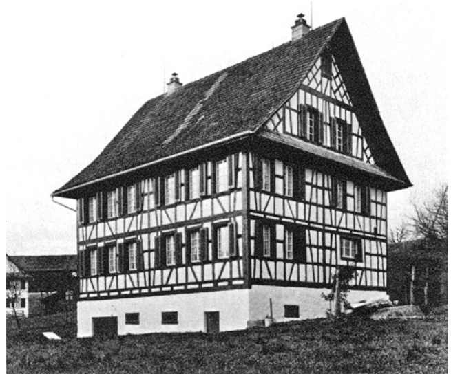
Rifferswil. Oberrifferswil. Bauernwohnhaus Vers.Nr. 116. Nach der Restaurierung 1973.
