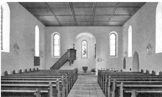
Flaach. Reformierte Kirche. Inneres. Oben: vor der Renovation; unten: nach der Renovation 1972.
