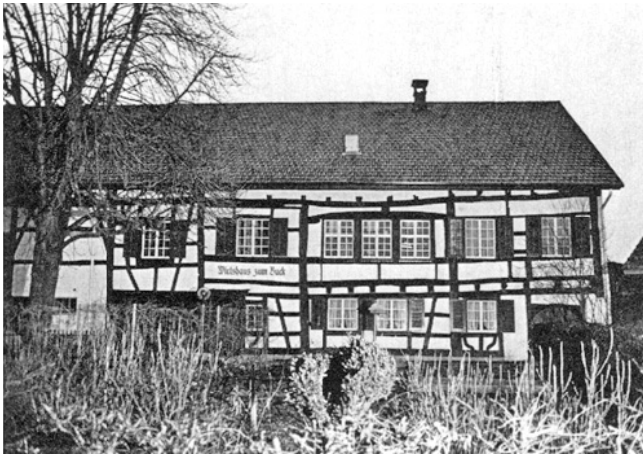
Rheinau, Buckstrasse. Wirtschaft «Zum Buck». Nach der Renovation 1972.
