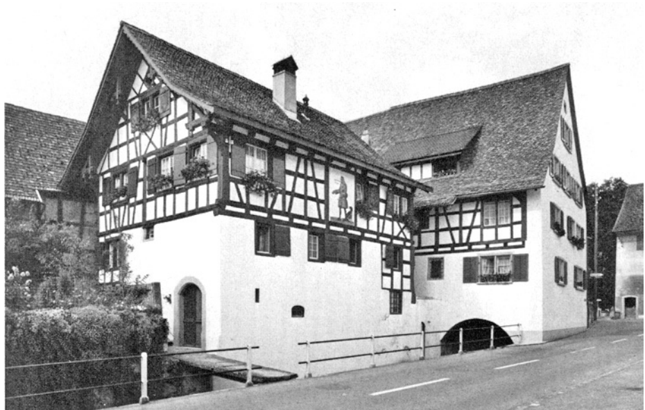
Otelfingen. Mitteldorf. Ehem. Amtshaus mit Wirtschaft «Zur Herrenstube». Nach der Renovation 1973.
