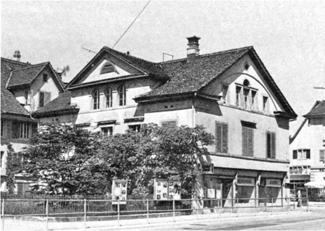
Wädenswil. Seestrasse III. Haus Vers.Nr. 368, abgebrochen 1971.
