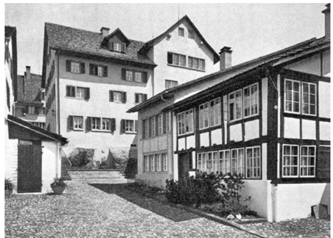
Grüningen. Ehem. Gerichtshaus. Aus Südwesten. Nach der Renovation 1974/75.
