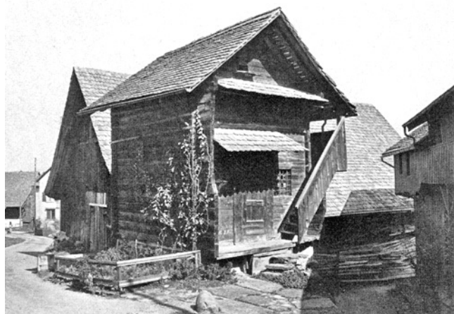
Oberrieden. Länzweg. Speicher Vers.Nr. 622. Vor der Renovation 1973.
