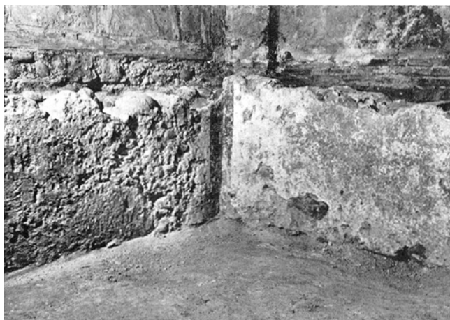
Kyburg. Ehem. Bauernhaus «Zur Farb». Alte Nordostecke mit schwarzem Farbband (spätgotisch), entdeckt im April 1973.
