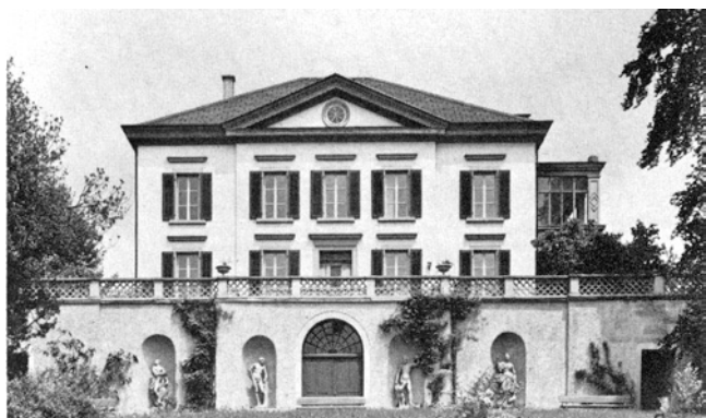
Männedorf Alte Landstrasse 220. Villa «Liebegg». Oben: vor der Restaurierung; Mitte: Bergseite; unten: Talseite, je nach der Restaurierung 1973.
