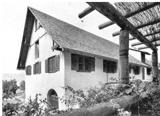
Herrliberg. Busenhard. Ehemalige Zehntenscheune. Oben: vor Renovation und Umbau; unten: nach Renovation und Umbau 1973/74.
