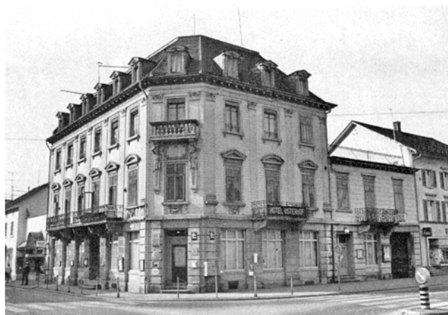
Uster. Bahnhofstrasse 2. Hotel Usterhof. Abgebrochen 1971.
