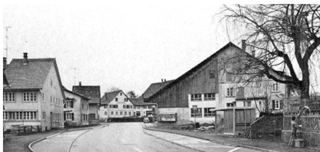
Mönchaltorf. Usterstrasse. Reformiertes Pfarrhaus. Oben: Zustand 1966; unten: Zustand nach dem Abbruch 1971.
