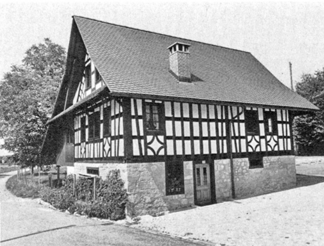
Mettmenstetten. Unterdorf. Riegelbau Vers. Nr. 490. Oben: vor der Renovation; unten: nach der Renovation 1970.
