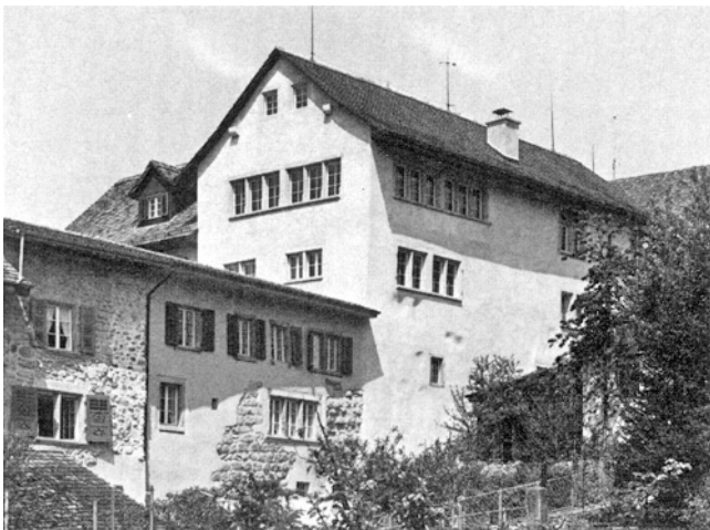
Grüningen. Ehemaliges Gerichtshaus. Ansicht aus Süden. Oben: vor der Renovation; unten: nach der Renovation 1974/75.
