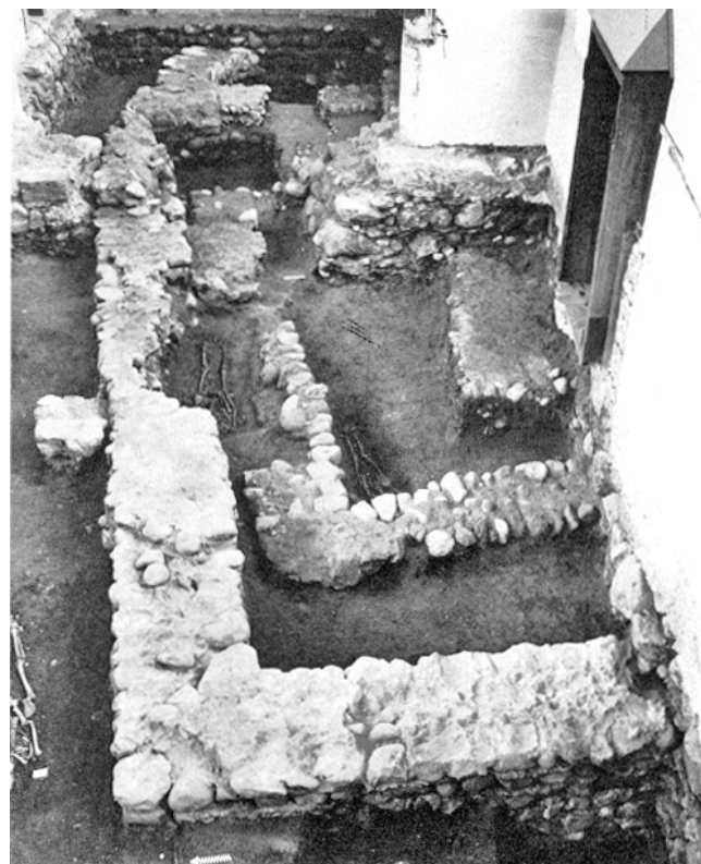
Fehraltorf. Reformierte Kirche. Gesamtansicht der freigelegten Fundamentreste der frühmittelalterlichen (Mitte) und hochmittelalterlichen Kapelle mit Fragment der Apsis im Osten (Hintergrund). Aus Westen.
