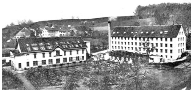
Thalwil. Gattikon. Ehem. Seidenweberei Vers. Nr. 1257, abgebrochen 1973.
