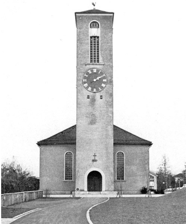
Dietikon. Reformierte Kirche. Vor der Renovation.
