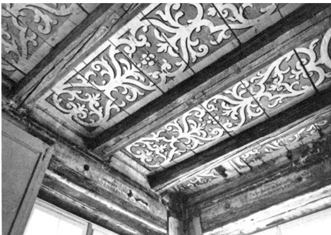
Zürich. Schönberggasse 15. Haus «Zum Oberen Schönenberg». Erdgeschoss. Südteil. Deckenmalerei aus der Bauzeit. Entdeckt 1963, wieder überdeckt 1965.
