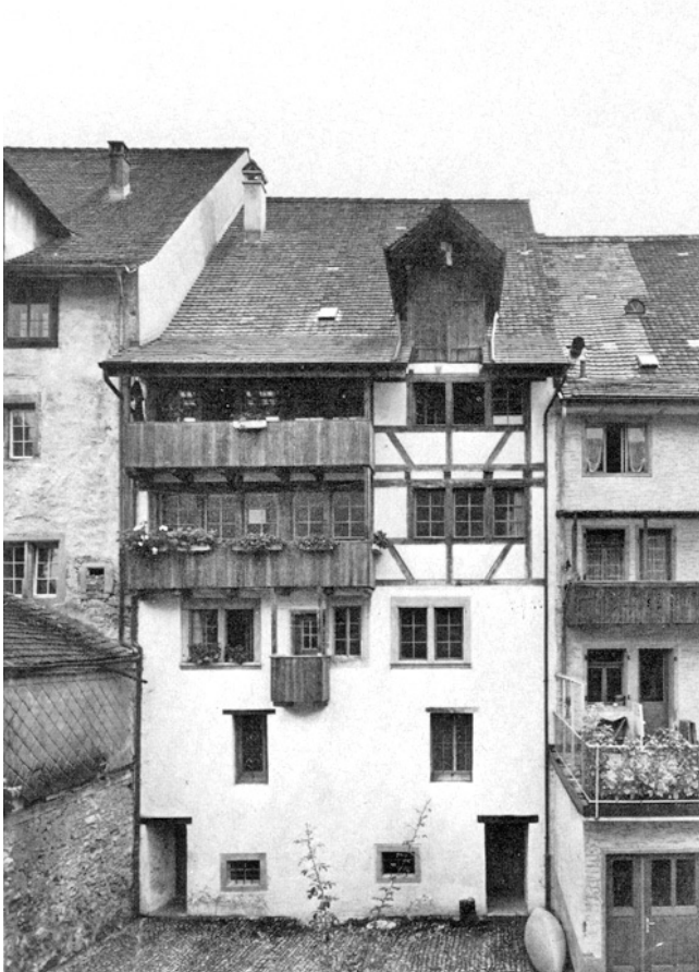
Eglisau. Obergasse 45. Ehem. Weinbauernhaus Vers. Nr. 560. Rückseite. Nach der Renovation 1968–71.
