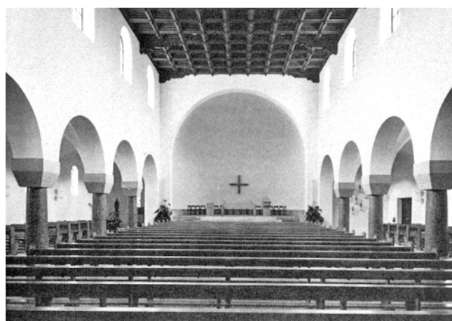
Wald. Katholische Kirche. Inneres. Oben: vor der Renovation; unten: nach der Renovation 1972/73.
