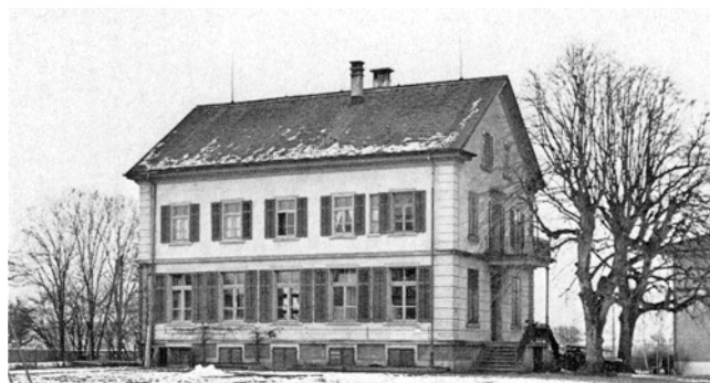
Uster. Nänikon. Stationsstrasse 49. Altes Schulhaus. Abgebrochen 1972.
