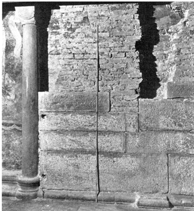
Zürich. Grossmünster. Hinterer Chor. Südwand-Westteil. Nach Entfernung des Verputzes.
