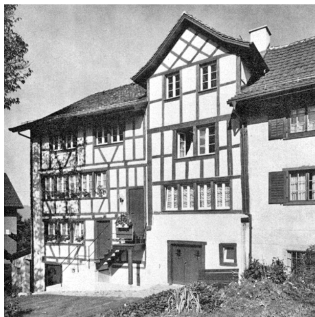
Küsnacht. Alte Landstrasse/Goldbacherstrasse. Haus Vers. Nr. 608/609. Nach der Restaurierung 1975. Oben: Rückseite; unten: Vorderseite.
