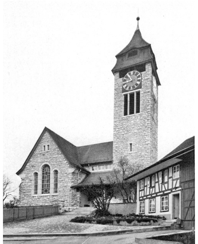
Brütten. Reformierte Kirche. Nach der Turmrenovation 1973.
