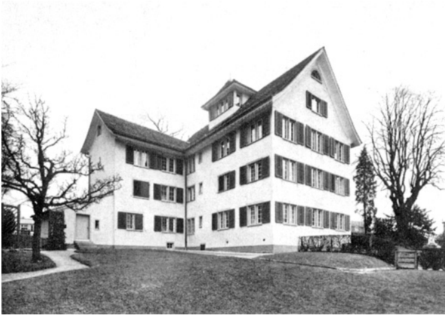
Zürich. Schönberggasse 15. Haus «Zum Oberen Schönenberg». Nach der Aussenrenovation 1971.
