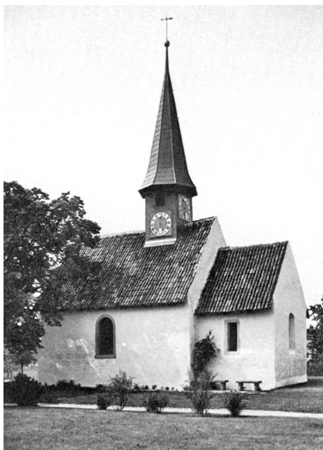
Nürensdorf. Breite. Oswaldkapelle. Nach der Restaurierung 1969/70.
