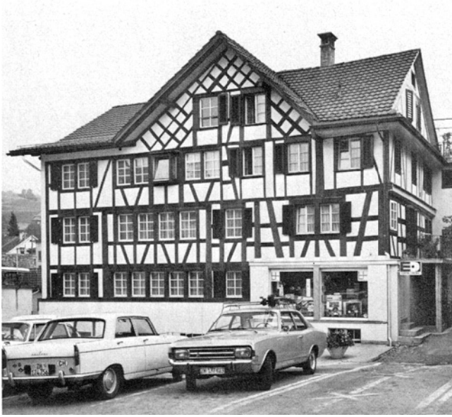
Wald. Dorfplatz. Bachtelstrasse 4/6. Doppelwohnhaus Vers.Nr. 1750/1751. Nach der Renovierung 1969/70.
