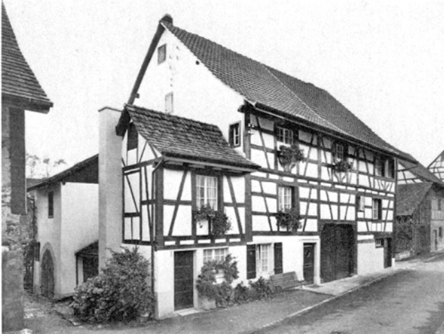
Eglisau. Burg. Ehem. Bauernhaus Vers.Nr. 393 a und b. Nach der Restaurierung 1973.
