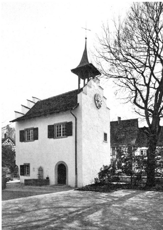
Andelfingen. Schloss. Ehem. Pförtnerhaus. Nach der Restaurierung 1971.
