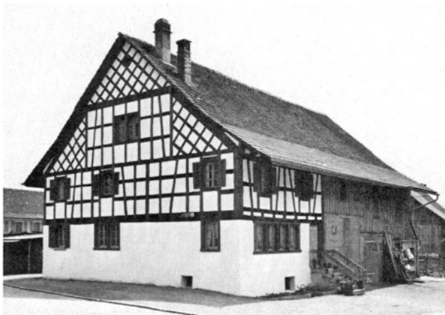
Kyburg. Bauernhaus Vers.Nr. 302. Nach der Renovation 1971.
