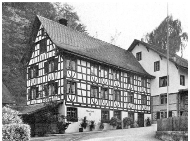
Eglisau. Seglingen. Sog. Lochmühle (ehem. Schlossmühle), Vers.Nr. 157. Oben: vor der Renovation; unten: nach der Renovation 1972.
