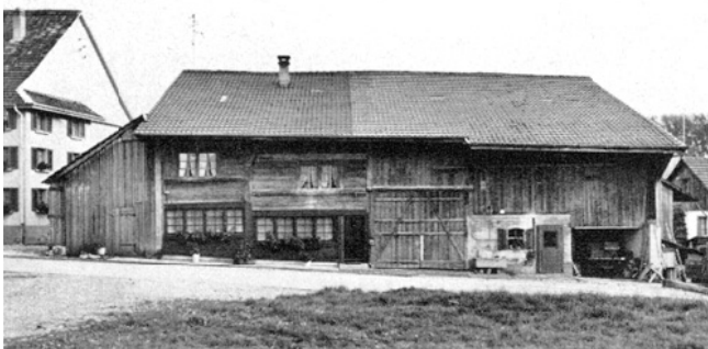
Greifensee. Im Hof. Bauernhaus Vers.Nr. 28. Nach der Renovation 1971.
