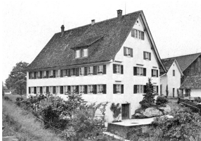
Stäfa. Uerikon. Obere Matt. Ehem. Doppelweibauernhaus Vers.Nr. 83. Nach der Restaurierung 1974.
