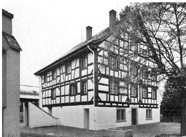
Bülach. Hallergasse 7. Reformiertes Pfarrhaus. Oben: vor der Renovation; unten: nach der Renovation 1974.
