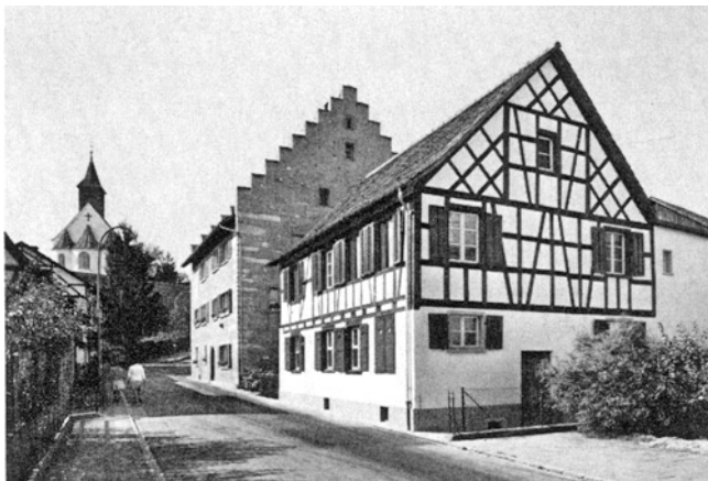
Rheinau, Poststrasse. Wohnhaus Vers.Nr. 64. Nach der Renovation 1972.
