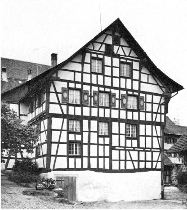
Andelfingen. Schlossgasse. Ehem. «Steinmühle». Nach der Restaurierung 1972.
