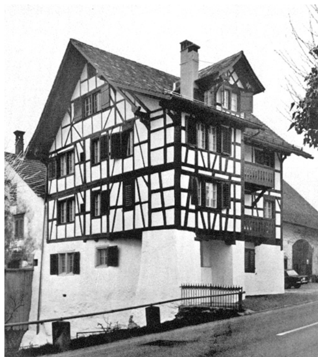
Grüningen. Ehemaliges Pfarrhaus. Nach der Renovation 1972.
