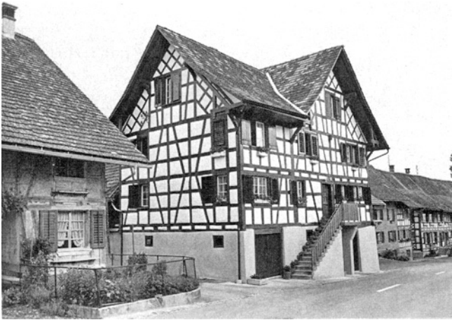
Waltalingen. Guntalingen. Bauernhaus Vers.Nr. 173. Nach der Renovation 1974.
