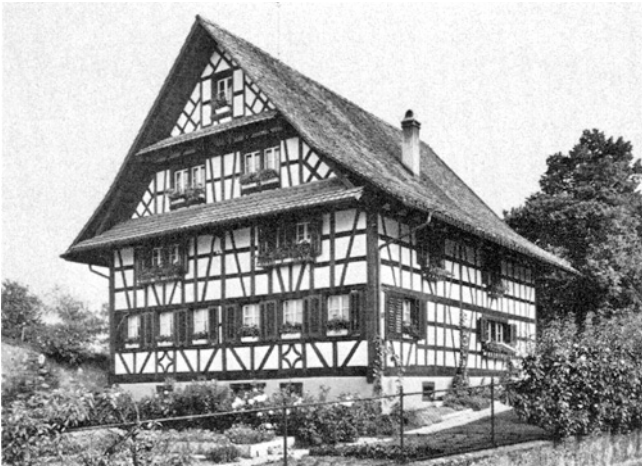
Hausen a.A. Ebertswil. Bauernwohnhaus Vers.Nr. 363. Nach der Restaurierung 1972.
