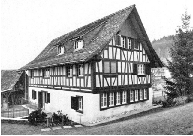
Uitikon. Ringlikon. Ehem. Bauernwohnhaus Vers.Nr. 3a. Nach der Renovation 1973.
