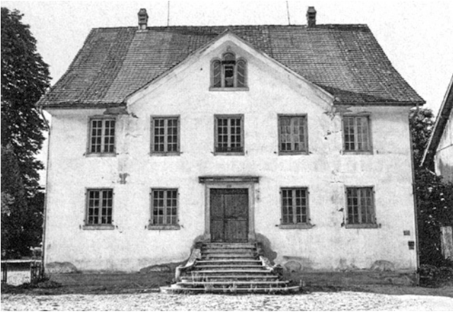
Zell. Kollbrunn. Ehem. Fabrikantenvilla Bühler Vers. Nr. 581). Abgebrochen 1974.
