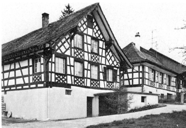
Altikon. Ehem. Schlosskeller. Nach der Renovation 1971.
