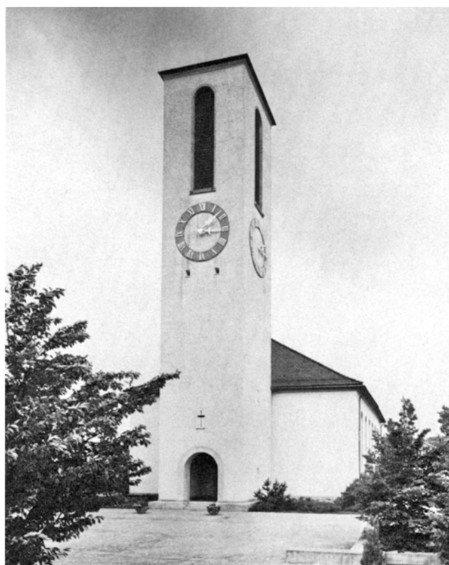
Dietikon. Reformierte Kirche. Nach der Renovation 1969/70.
