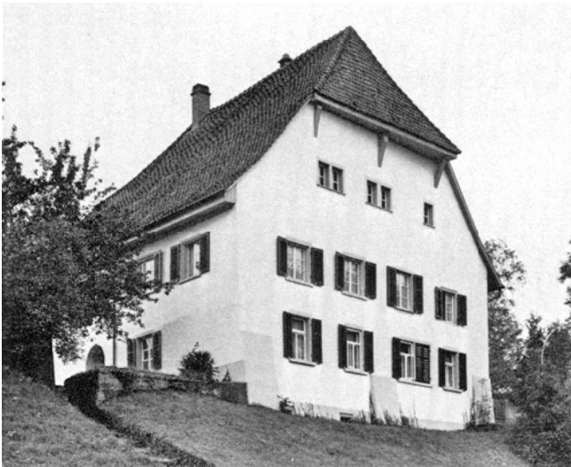
Rheinau. Schulstrasse. Haus «Zur Stube». Nach der Renovation 1973.
