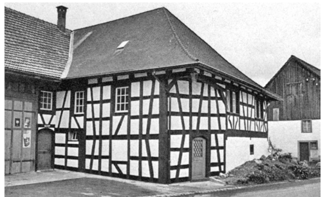
Zell. Ober-Langenhard. Restaurant «Zum Obstgarten». Nach der Renovation 1971.
