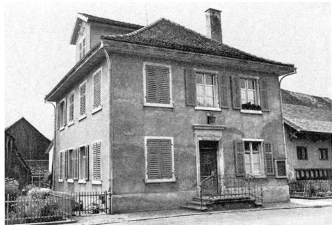
Wangen. Hegnaustrasse. Altes Schulhaus (Vers.Nr. 93), abgebrochen 1970.
