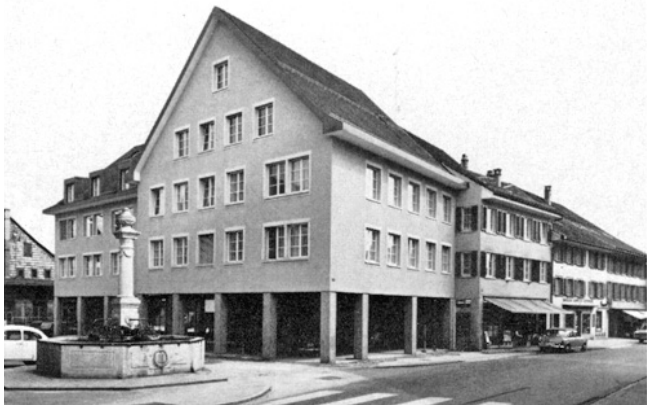
Bülach. Brunngasse 2/Marktgasse 27. Haus Marktgasse 27 (Eckhaus), links Haus Brunngasse 2. Oben: vor dem Abbruch 1969; unten: Neubau von 1971.
