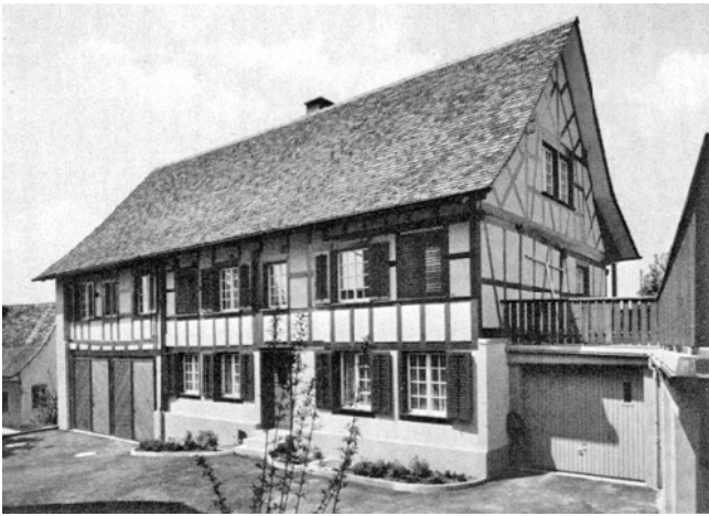
Laufen-Uhwiesen. Uhwiesen. Haus «Zum Kloster». Nach der Restaurierung 1968.
