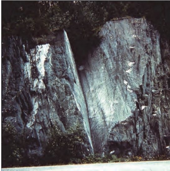
Abb. 3. Versagen einer Felsböschung durch Gleiten eines Kluttkörpers auf zwei Trennflächen (Pfeile stellen die Fallpfeile der beiden Trennflächen dar)
