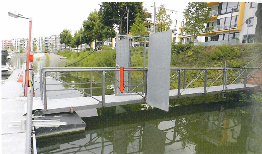
Abb. 4: Steg im Mainzer Winterhafen, unter welchem Rauchschnalben an der mit Pfeil markierten Stelle ihr Nest angelegt hatten. Mainz, 26. Juli 2014. Foto: Verf.
