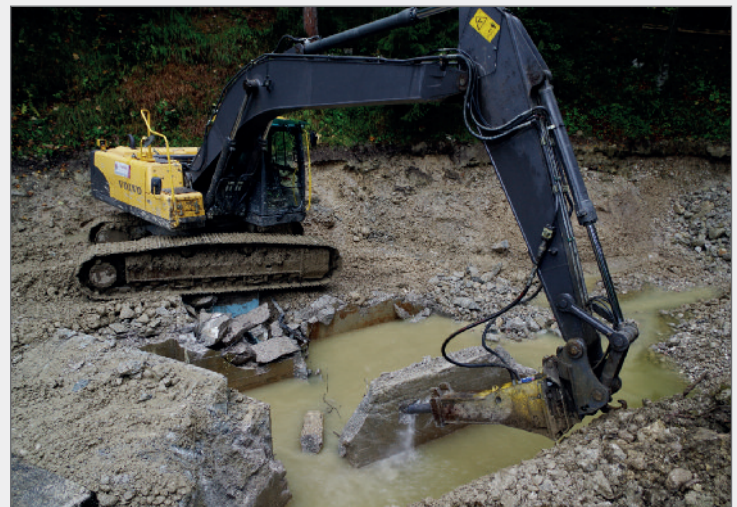
Abb. 12: Abbruch der Quellkammer mit einem schweren Hydraulikhammer. Foto: Robert Seebacher Fig. 12: Demolition of the source chamber using a heavy hydraulic hammer.
