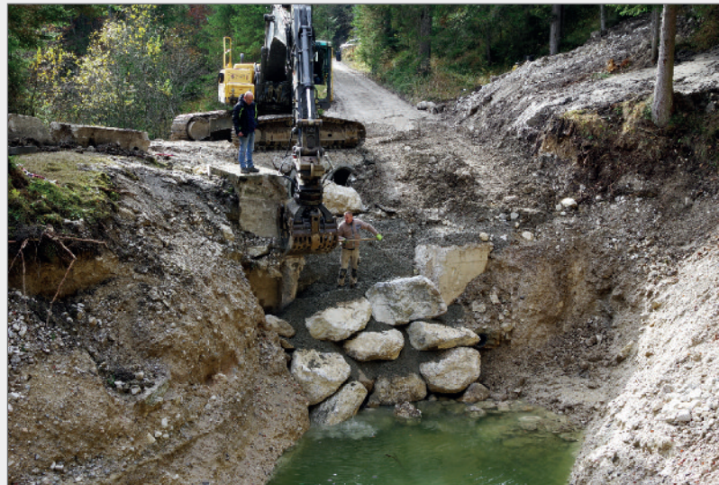
Abb. 14: Für den neuen Überlauf des Quelltopfes musste eine Steinschichtung mit Betonhinterfüllung aufgebaut werden. Foto: Robert Seebacher Fig. 14: A stone dressing with concrete backfilling was made for the new overflow of the spring pot.
