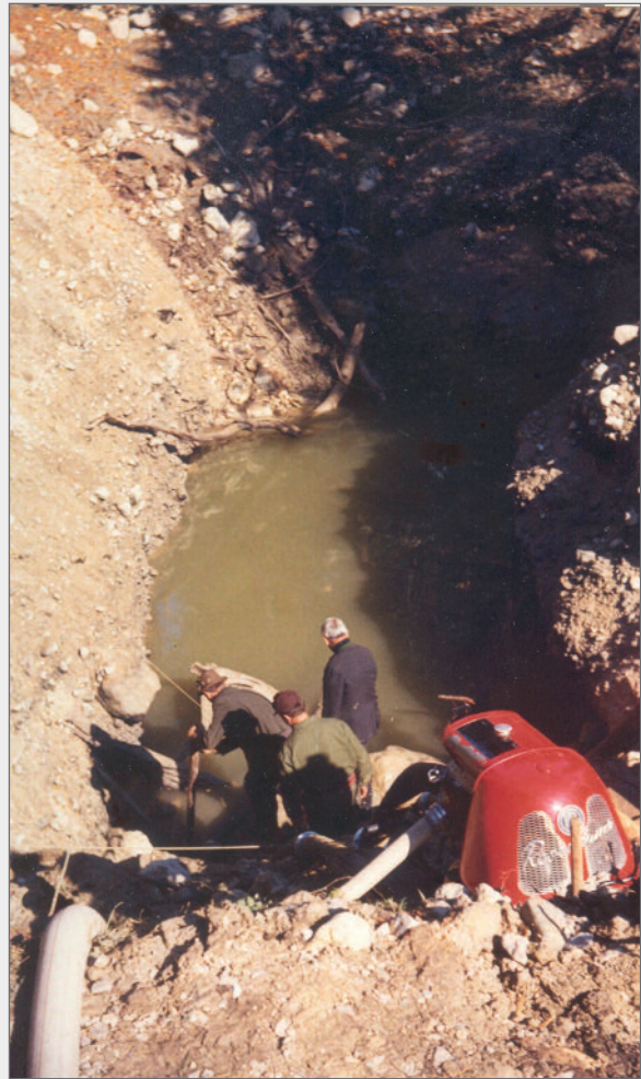
Abb. 8: Erste Bauarbeiten im teilweise trockengelegten Quelltopf des Sagtümpels im Jahre 1975.
