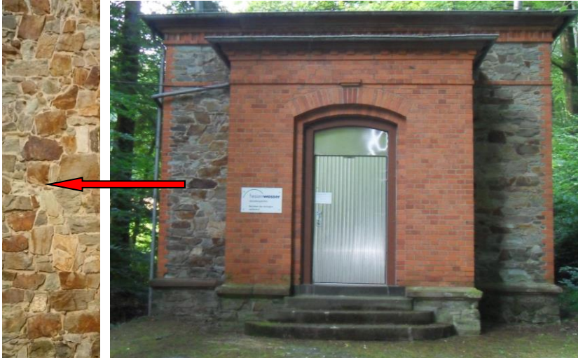
Abbildung 11: Portal des Münzbergstollens mit vermauertem Taunusquarzit. Die bräunlichen Farben gehen auf die Ausfällung Fe-reicher Lösungen auf Kluftflächen zurück; Foto: Toussaint.
