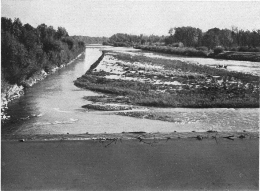
Abb. 18. Ampermündung bei Isareck. In höherliegendem Bett zieht die dem Ammersee entströmende Amper auf kurzer Strecke neben der Isar her und mündet über ein etwa 1,5 m hohes Sturzwehr in diese ein
