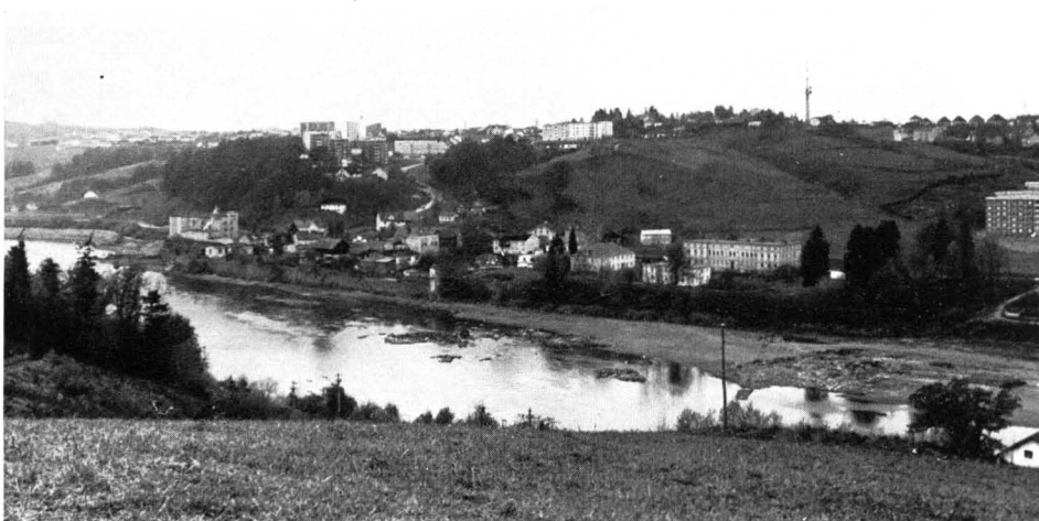
Höhere Innterrasse unterhalb Staustufe Ingling
