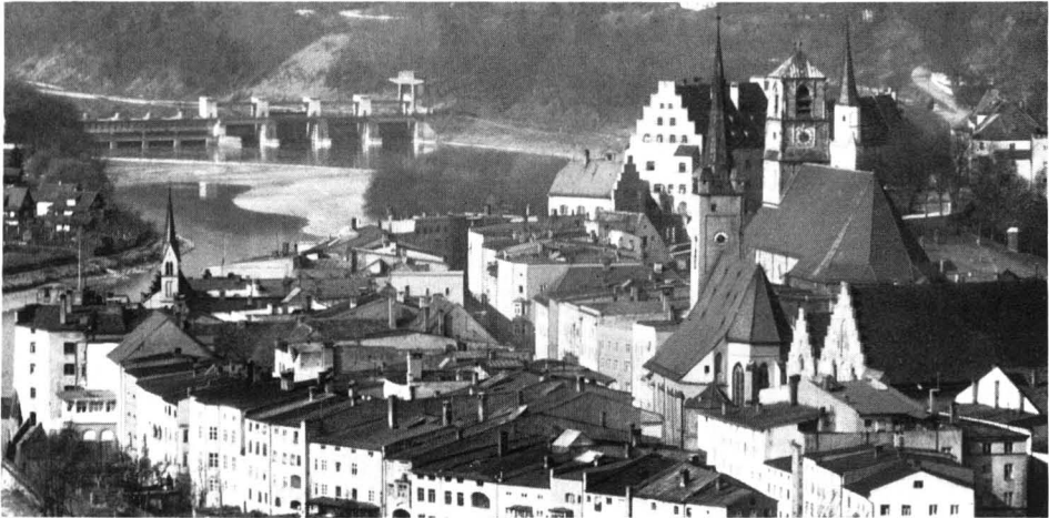
Wasserburg. Spätgotische Stadt mit oberhalb liegender Kraftwerkstufe
