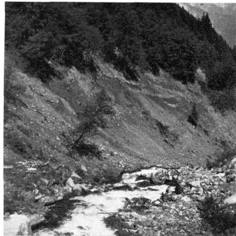
Abb. 6 Uferanbruch in der Talverfüllung
