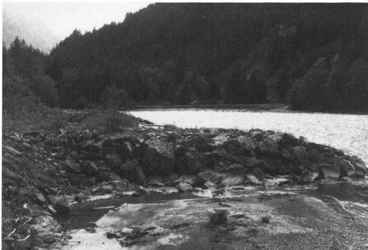
Die vor der Regulierung offenen Kiesflächen verlanden und verbuschen rasch. Foto: Scheurmann.
