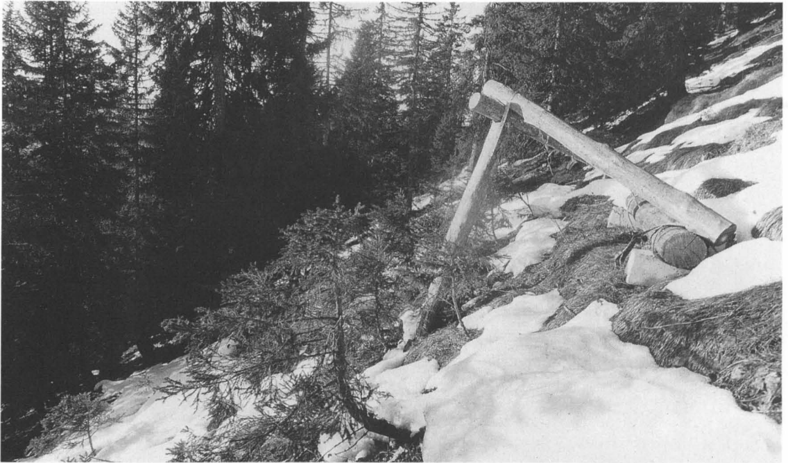
Abb. 18: Schutzwaldsanierung mit hölzernen Bauwerken. Viele Schutzwälder sind schon so lückig, daß der Schnee bergab kriechen und dabei junge Bäume brechen oder herausreißen kann. Durch hölzerne Bauwerke kann dies etwa 25 Jahre lang verhindert werden. Bis dahin muß der junge Wald so groß und so dicht sein, daß er die Schutzfunktion ausreichend übernehmen kann.
