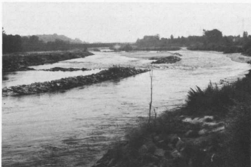
Abb. 12: Die Traun unterhalb der ÖBB-Brücke mit Bühnenfeld und Schotterbänken (18. Juli 1977).
