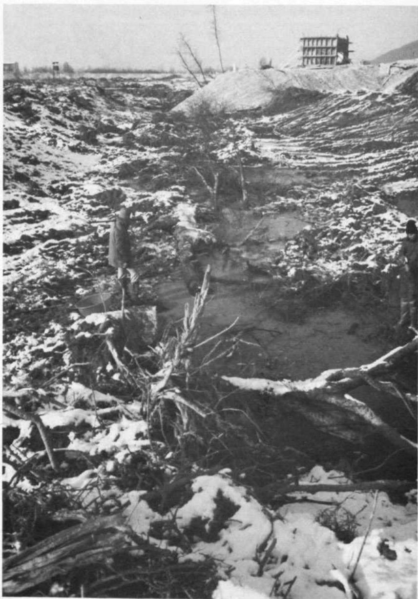
Abb. 3: Ein Altarmrest wird im Bereich des Hauptbauwerkes* des KW Abwinden zugeschüttet (24. November 1975). Alle Fotos vom Verfasser
