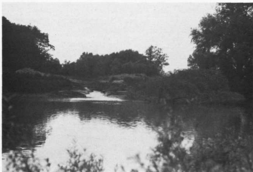
Abb. 4: Im Bereich des Stromkilometers 2118,4 wird Pumpwasser des Hauptbauwerkes in den Altarm „Hinterwasser“ eingeleitet (24. Juni 1976).
