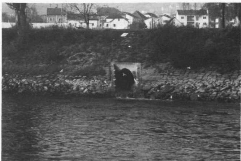
Abb. 9: Am linken Donauufer bei Stromkilometer 2132,8 mündet der Abwasserkanal Urfahr ein (9. Dezember 1975).
