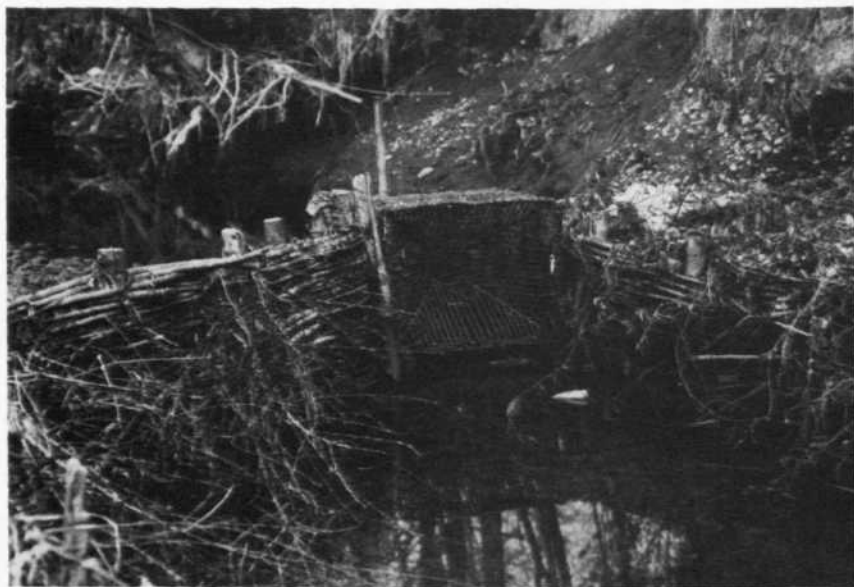
Abb. 15: Trockengefallene Reusenanlage in der Kreams (Post 54 des Fischereireviere Traun-Linz – 18. April 1978).
