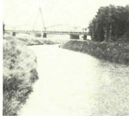
Abb. 7: Umleitungsgraben bei der Steyregger Brücke (Juli 1980)
