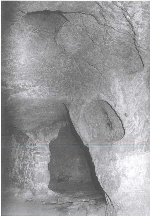
Abb. 4 (links): Seitenraum zu Keller Nr. 2; im Hauptgang (vorn) Luftschacht, Deckennut und Lichtnische.
