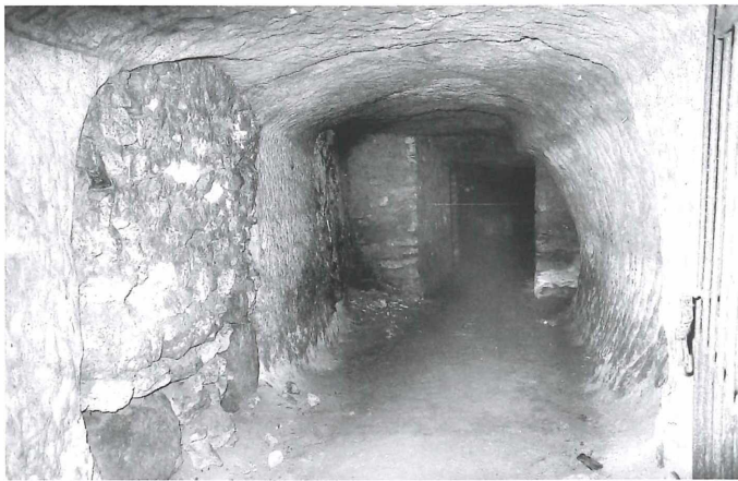
Abb. 21: Eingangsbereich von Keller Nr. 12 mit den alt vermauerten Durchgängen auf der linken Seite
