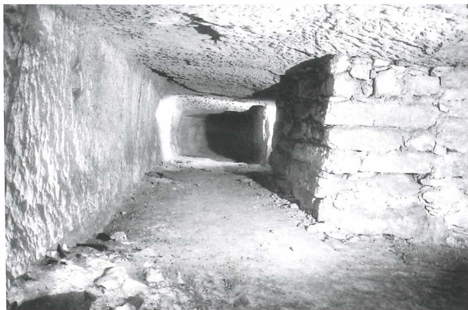
Abb. 16: Keller Nr. 7, Zyklopenmauer im Inneren; dahinter die Gangteilung
