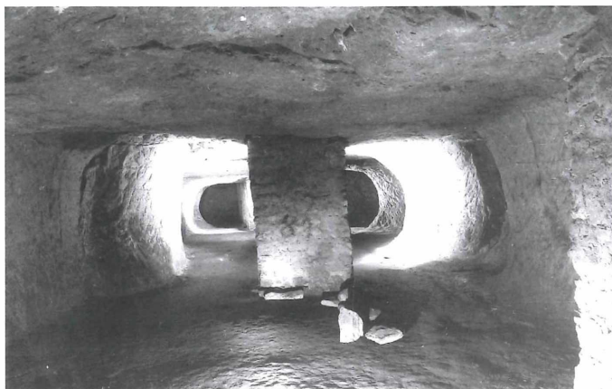
Abb. 22: Keller Nr. 12, Gang mit Stützmauerwerk
