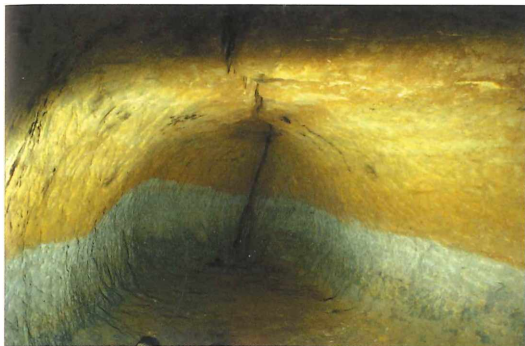
Abb. 33, 34: Farbigeit der Sandsteinlagen am Ende von Keller Nr. 3 (südlicher Bereich)
