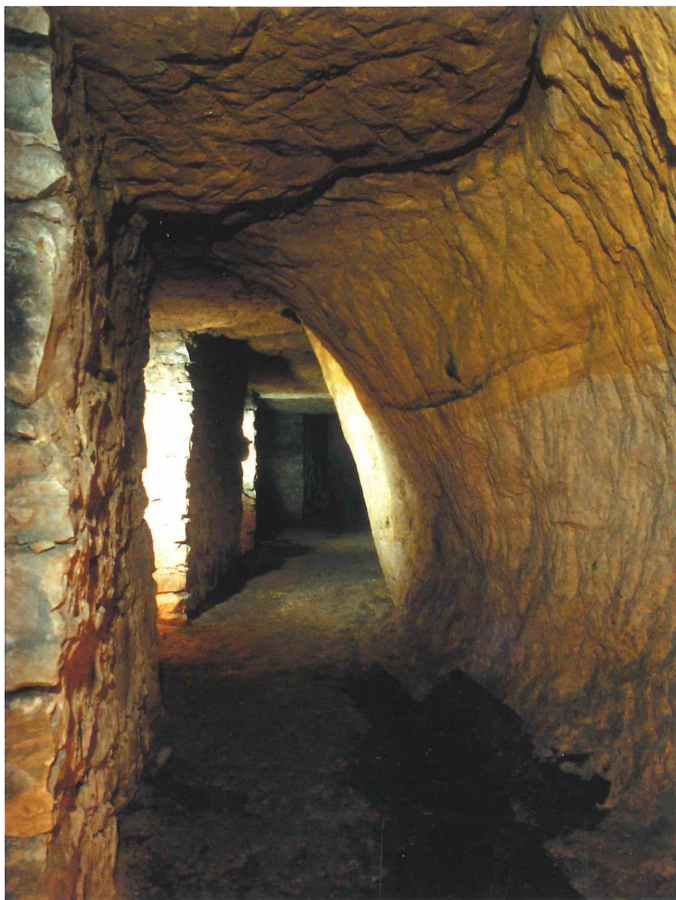
Abb. 12: Kellergang Nr. 3, Blick nach Nord, mit Stützmauern; an Decke und Wand verschiedenfarbige Sandsteinlagen, mit dünnem Tonbändchen in Wandmitte
