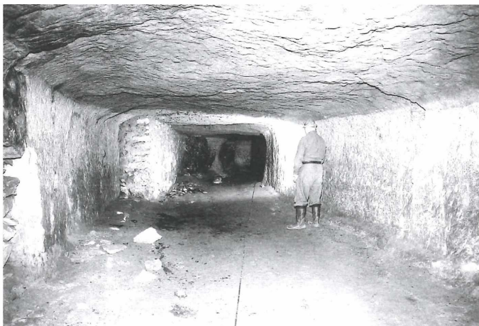
Abb. 19: Hauptraum in Keller Nr. 11. Links Stützmauerwerk, ganz hinten ehemaliger (vermauerter) Durchbruch zu Nr. 9
