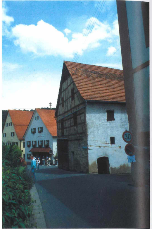
Abb. 9: Zehntscheune mit oberem Kellereingang
