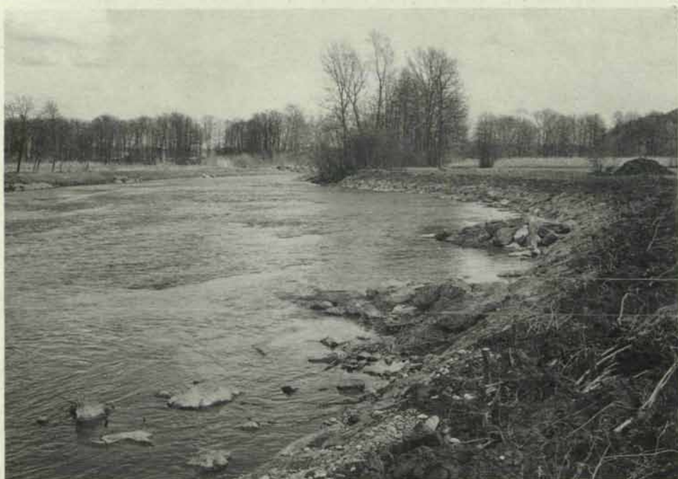
Naturngemäße Sanierung eines Uferanbruches durch Buhnen und Spreitlagen (Mündungsstrecke der Sulm).
