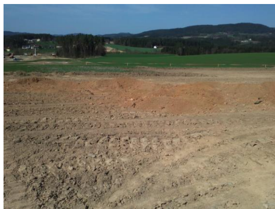
Abb. 1: Der Fundbereich mit abgedecktem Humus. Der rötlich verfärbte Aushub zeigt den ungefähren Verlauf des Quarzganges an
