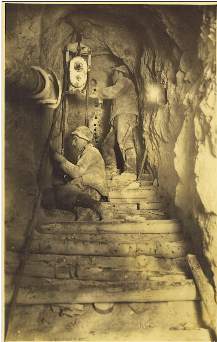
Abb. 9: Streckenvortrieb im Aufbruch, Bergbau Ischl, Foto von Hans Köberl 1936, Archiv Salinen Austria AG
