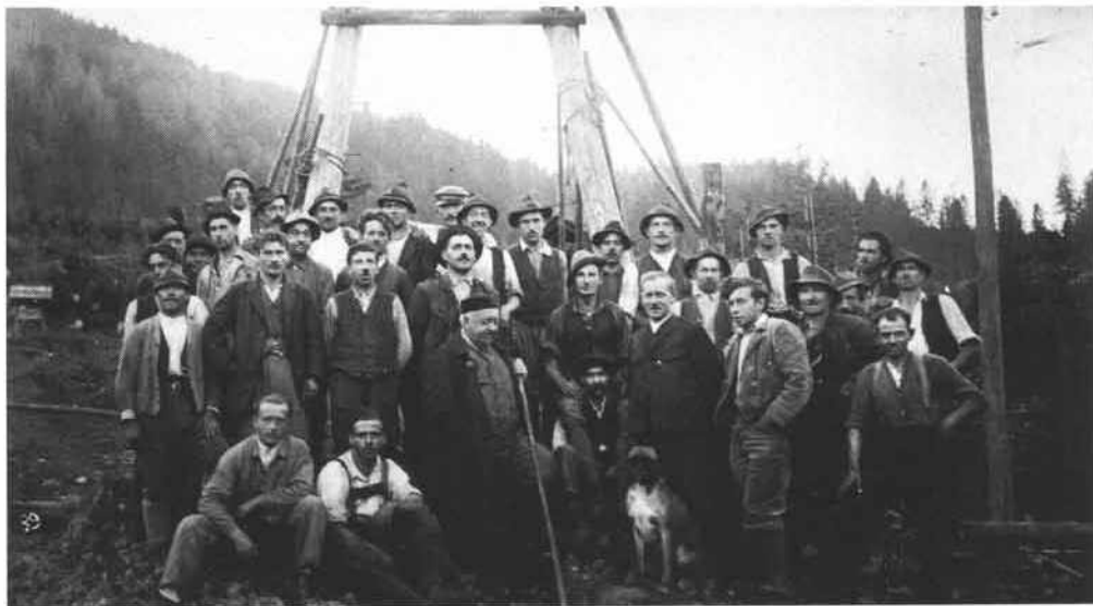
Abb. 5: Unterlaussa. Neubau der Seilbahn zwischen dem Steinkohlenbergbau unterm Hochkogel (Grubenfeld „Josef“ im Sandl) und dem Ort Unterlaussa. Aufnahme wahrscheinlich im Herbst 1934 nahe beim Bergbaugebiet; vorne in der Mitte: Betriebsleiter Josef Koestler (mit schwarzer Kappe und Bergstock). Unbezeichnete und undatierte Fotografie im Besitz von H. J. Köstler.
