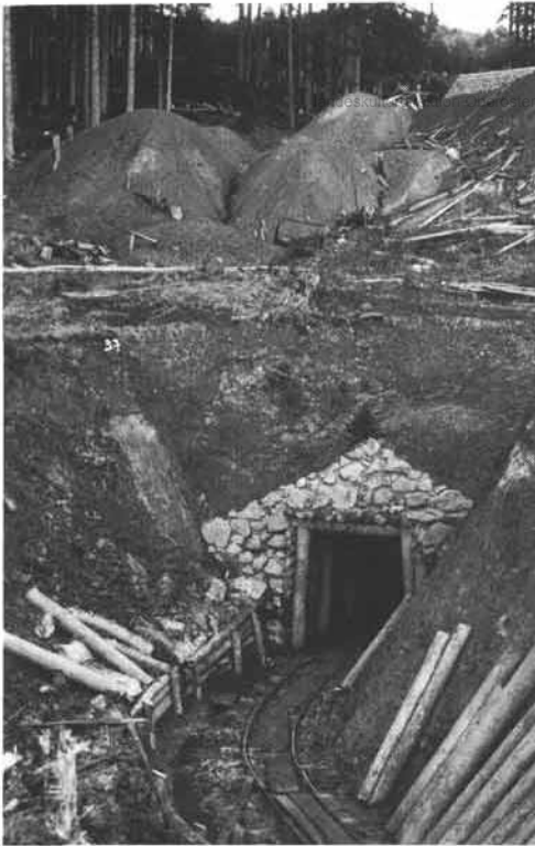
Abb. 3: Unterlaussa. Steinkohlenbergbau unterm Hochkogel, Grubenfeld „Josef“ im Sandl. Mundloch des Barbara-Stollens (?) mit Geleise der Grubenbahn; darüber Halden beim Karl-Stollen. Aufnahme wahrscheinlich im Herbst 1934. Unbezeichnete und undatierte Fotografie im Besitz von H. J. Köstler.
