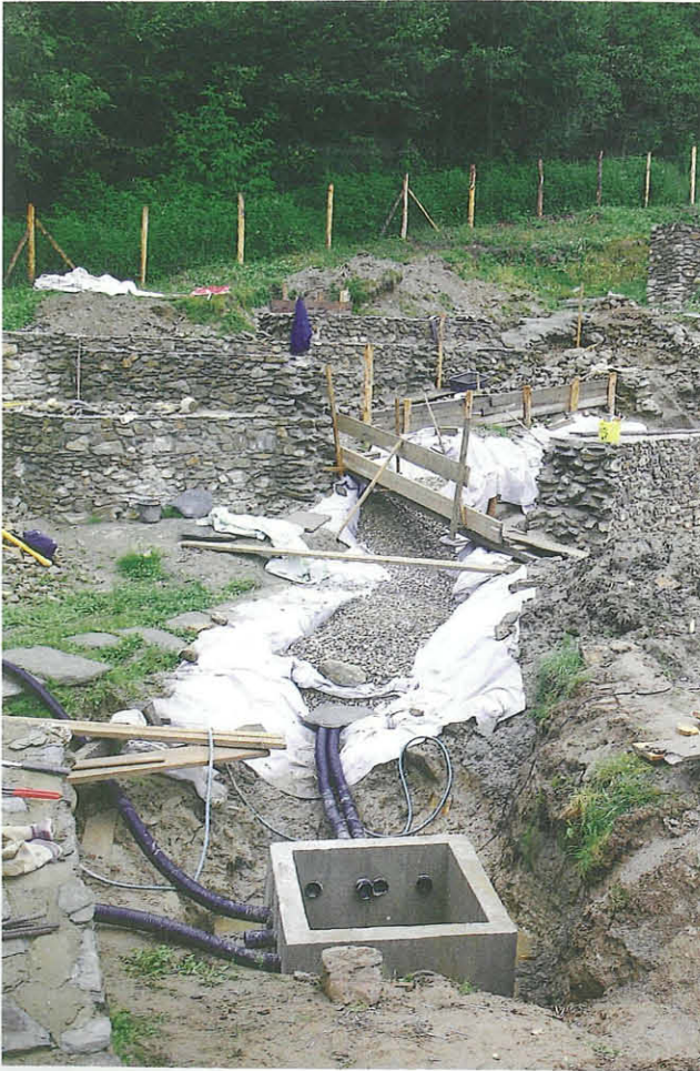
Abb. 5: Drainagierungen und Sammelschacht im Bereich Nordtor. Blick aus Südwesten. Aufn. R. Barlovits
