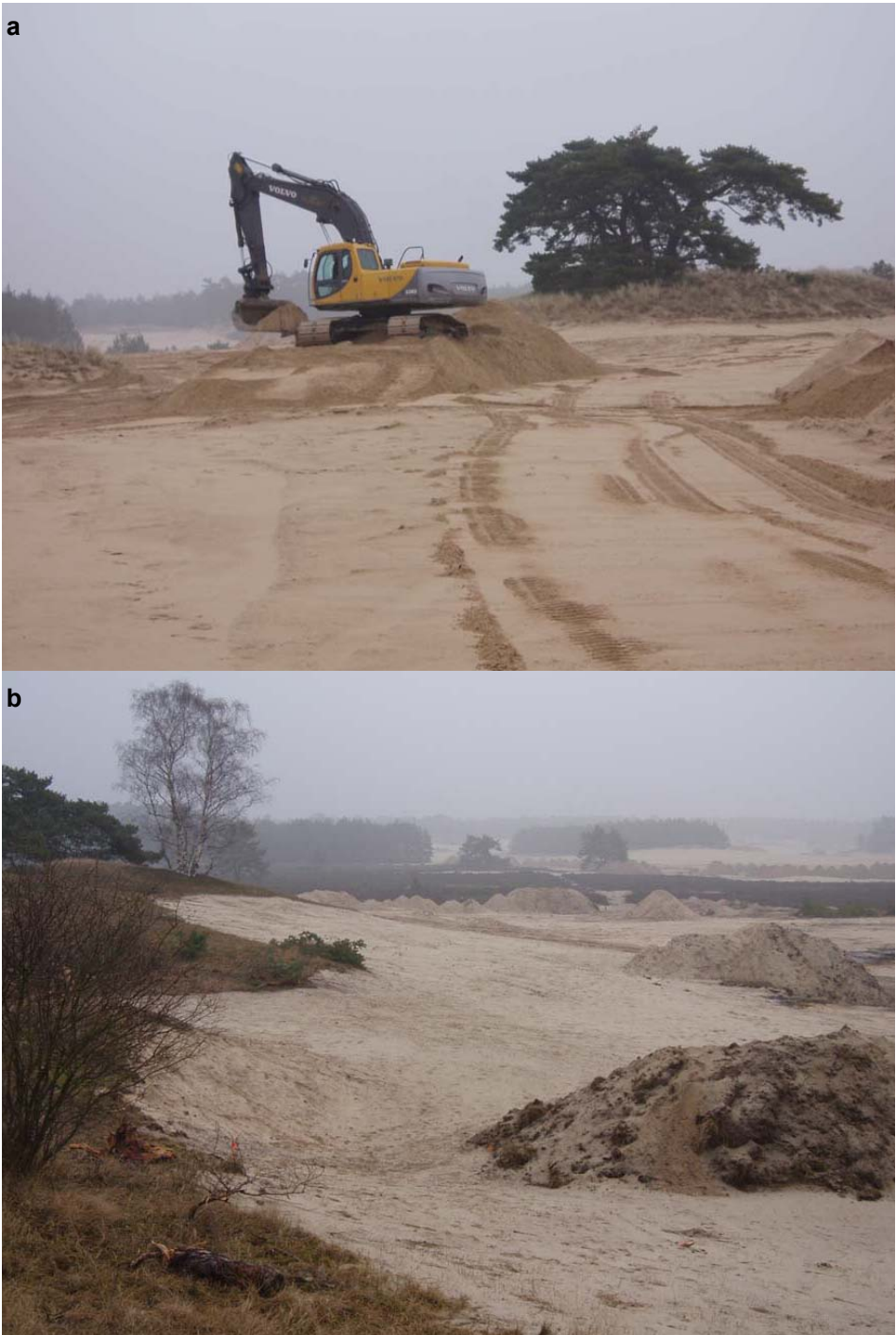
Fig. 10: Management measures carried out. a: topsoil removal at the borderline between dry heath and drift sand in 2009. b: sieving machine in action with piles of sand left after the sieving. Abb. 10: Durchgeführte Managementmaßnahmen. a. Oberbodenabtrag an der Grenze zwischen Trockenheide und mobiler Binnendüne. b. Sandhaufen nach der Einsatz der Siebmaschine.
