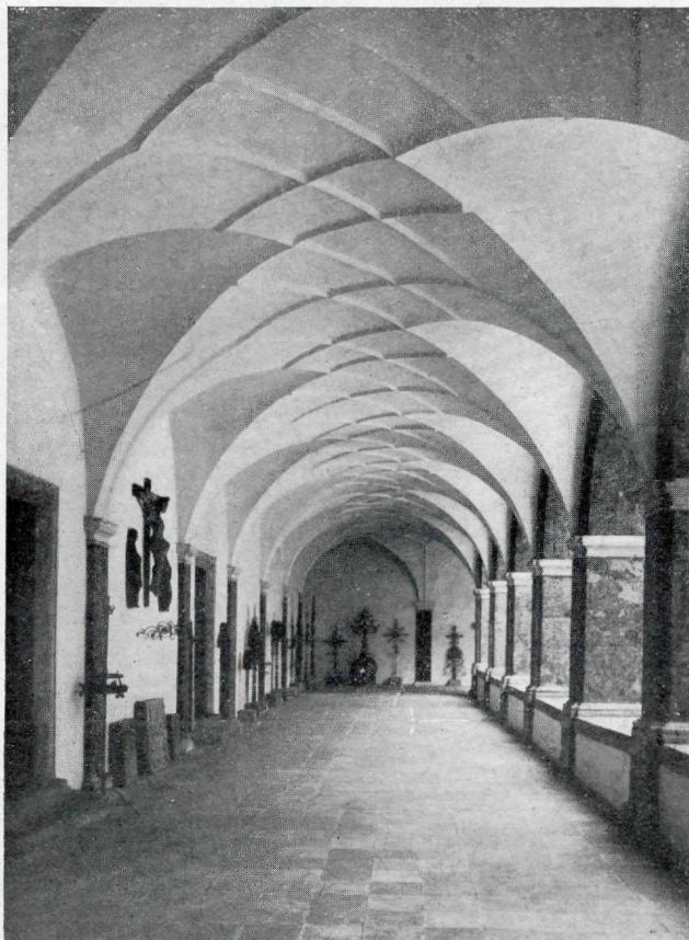
Bild 1. Netzgratgewölbe im Kreuzgang des „Neuen Stifts“ (Volkskunstmuseum), Innsbruck, Universitätsstraße 2 (vgl. S. 182). Aufn. A. Stockhammer, Hall i. T.
