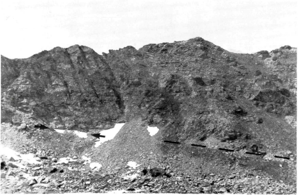
Abb. 2 Das Sideritlager oberhalb des Eisenkars im flach bergwärts fallenden Quarzphyllit. Pfeil = Mundloch der Zeche. Ausbißlinie markiert.
