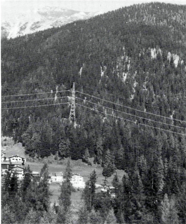
Abb. 1 Das Bergbaugebiet Gand von Süden: Im Vordergrund der Weiler Obergand. Darüber der zur Orientierung dienende Mast der Hochspannungsleitung. Foto Dr. H. Kuntscher
