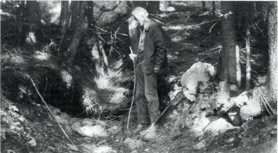
Abb. 5 Zugang zum verbrochenen Stollen oberhalb des von Obergand heraufführenden Weges. Foto Dr. H. Kuntscher
