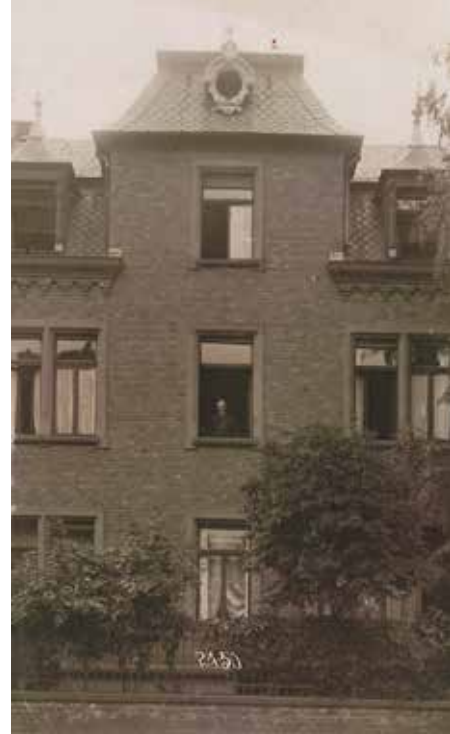
Haus Dönges, Klappacher Straße 22 (im Zweiten Weltkrieg zerstört)
