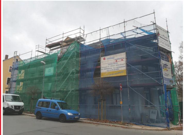
Dachsanierung abgeschlossen | Fassadeninstandsetzung begonnen (11/2018)
