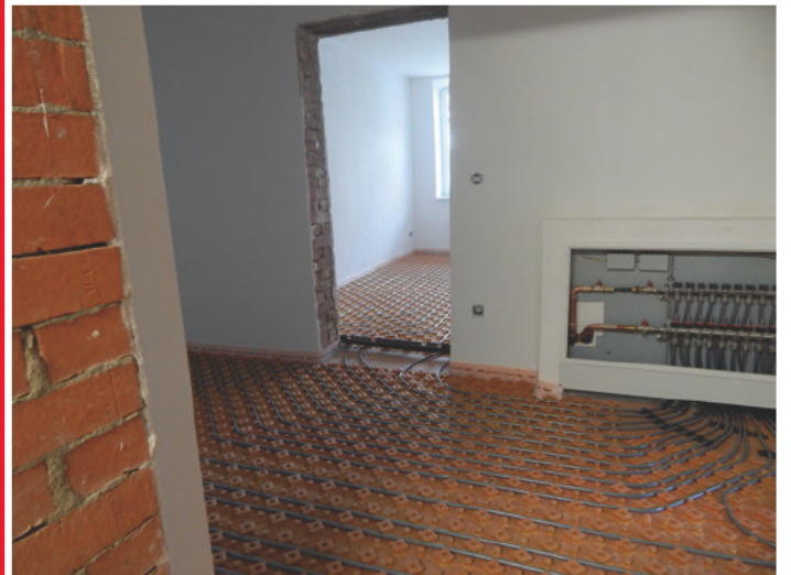
Verlegung der Fußbodenheizung in der Erdgeschosswohnung (02/2019)
