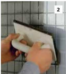
StoColl FM-S mit einem Reibebrett mit Zellkautschuckbelag als Schlämmverfugung in den kompletten Fugenquerschnitt einreiben. Hinweis: Um eine Farbgleichheit zu erzielen, ist eine gleichmäßige Verarbeitung unerlässlich. Um Farbdifferenzen zu verhindern, während der Verarbeitung kein zusätzliches Wasser zugeben.
