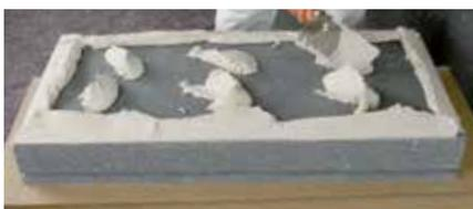
Die Kleber-Kontaktfläche muss  $\geq 60\%$  betragen. Den Kleber mittels Punkt-Rand-Verklebung wie folgt auftragen: Einen umlaufenden Kleberwulst (ca. 5 cm) und mindestens 6 Kleberpunkte ( $\varnothing$  ca. 19 cm) symmetrisch auf der Dämmplattenrückseite verteilen.
