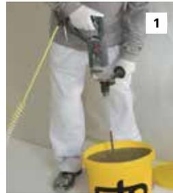
Ca. 4 l Wasser/25-kg-Sack vorbereiten. Anschließend StoColl FM-E ca. 4 Minuten mit dem Rührwerk untermischen. Ca. 3 Minuten reifen lassen und anschließend nochmals gut durchmischen.
