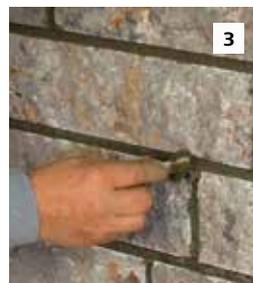
Wenn der Fugenmörtel angezogen ist, überstehendes Material abkratzen. Anschließend den Fugenmörtel verdichten.
