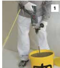
2–3 l Wasser / 25-kg-Sack vorbereiten. Anschließend StoColl FM-K ca. 2 Minuten mit dem Rührwerk untermischen. Ca. 3 Minuten reifen lassen und anschließend nochmals gut durchmischen. Hinweis: langsam drehendes Rührwerk (ca. 400 U/min) verwenden und bei stark pigmentierten Sonderfarbtönen die geforderte Wassermenge mit 23 kg Trockenmörtel vormischen. Nach der Reifezeit die Restmenge Trockenmörtel einrühren.
