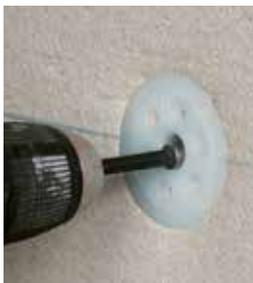
Die Dübel setzen. Der Dübelteller muss dabei leicht versenkt werden. Anschließend den EPS-Stopfen über der Dübelschraube planeben einsetzen.
