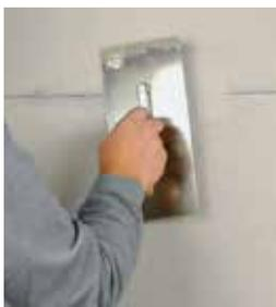
Die Dübelteller mit dem Unterputz oder StoColl KM vollflächig abspachteln, damit eine ebene Unterputzlage entsteht.
