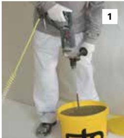
Pro 25-kg-Sack ca. 5 l Wasser vorbereiten. Anschließend StoColl FM-S ca. 2 Minuten untermischen, mit dem Rührwerk ca. 3 Minuten reifen lassen und erneut gut durchmischen.
