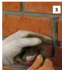
Stoßfugen per Hand mithilfe einer Fugenkelle verfugen. Anschließend den Fugenmörtel mit dem Fugeisen verdichten. Hinweis: Abhängig vom Belag muss die Verfugung in 2 Lagen erfolgen.
