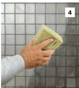
Das Glasmosaik abschließend nochmals mit einem feuchten Fliesenschwamm abreiben. Bei Bedarf wiederholen. Die Fläche anschließend mit einem sauberen und trockenen Mikrofasertuch nachpolieren.
