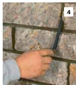
Fugenmörtel mit der Fugenkelle in den Stoß- und Lagerfugen verdichten.
