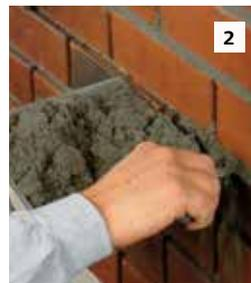
Lagerfuge mithilfe einer Fugenkelle verfugen. Anschließend den Fugenmörtel mit der Fugenkelle verdichten. Hinweis: Um eine Farbgleichheit zu erzielen, ist eine gleichmäßige Verarbeitung unerlässlich. Um Farbdifferenzen zu verhindern, während der Verarbeitung kein zusätzliches Wasser zugeben. Hinweis: Abhängig vom Belag muss die Verfugung in 2 Lagen erfolgen.
