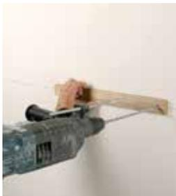
Am Tag nach dem Aufbringen der Bewehrung/Armierung die Dübel in den leicht angesteiften Unterputz setzen. Dafür den horizontalen Abstand auf Basis der benötigten Dübelanzahl pro m<sup>2</sup> mittels Schnurschlag anzeichnen. Dübellöcher mithilfe einer Lehre im geforderten vertikalen Abstand bohren.
