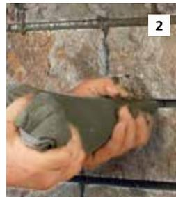
Fugenmörtel in die Kartusche (hier Spritzbeutel) einfüllen. Anschließend den Mörtel in die Stoß- und Lagerfugen füllen.
